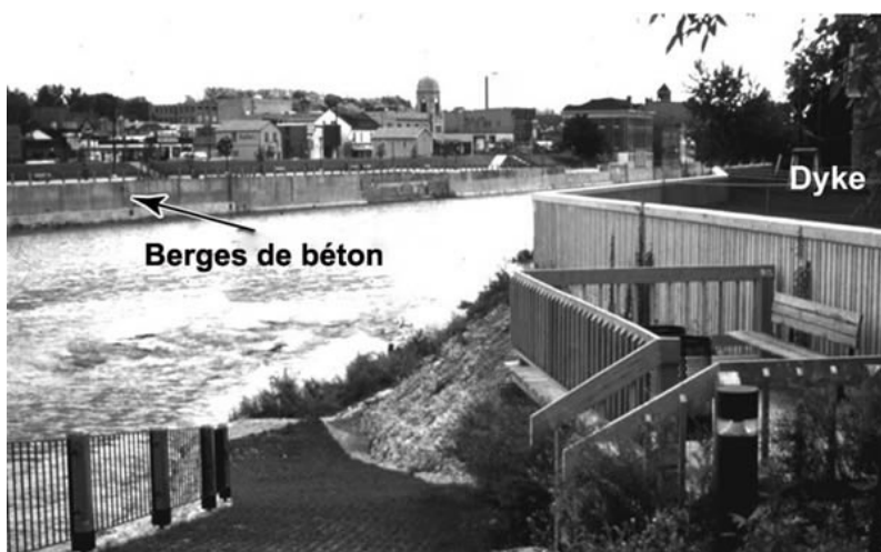
Figure 12 : Photo d'un lit de rivière a été creusé artificiellement, les berges ont été construites à l'aide de béton et la plaine inondable a été endiguée afin d'augmenter la capacité de débit du lit le long d'un tronçon de la rivière Grand, Cambridge, Ontario
