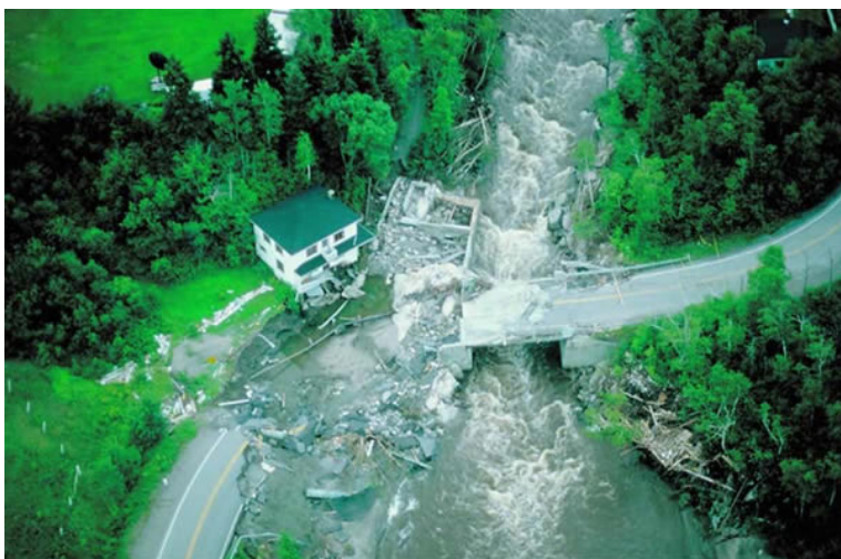
Figure 6 : Photo d'un traversée de pont ayant subi des dommages aux endroits où le resserrement formé par les culées de pont a entraîné le débordement des eaux de crue par-dessus le pont, région du Saguenay, juillet 1996
