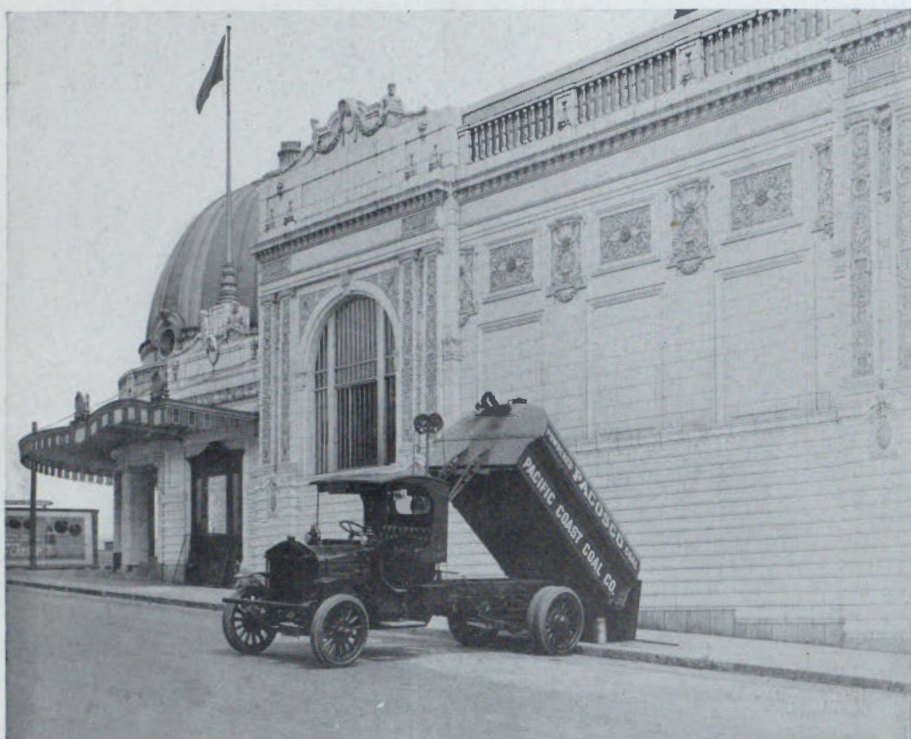
LIVRAISON DE CHARBON PULVÉRISÉ PAR CAMION AUTOMOBILE The Crystal Pool, ou un établissement de bains à Seattle, Wash.
