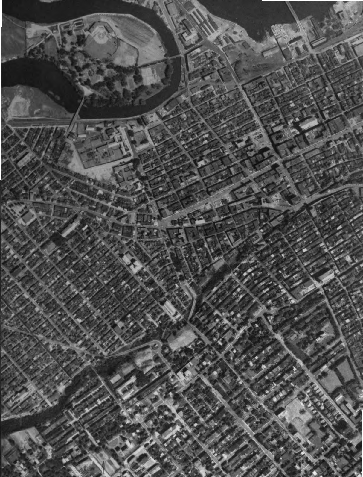
Figure 4. Vue aérienne des quartiers Saint-Roch, Saint-Sauveur et Saint-Jean-Baptiste, zones de forte densité de construction; plus de 60 p. 100 de la superficie est occupée par des toits dans un bloc. (Photo: ARC)
