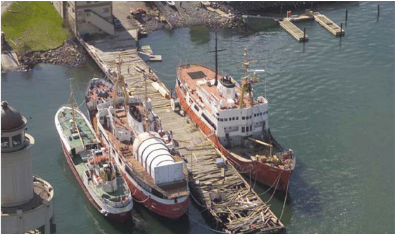
Figure 6 : Une onde de tempête provoque des dommages à un quai du port de Halifax. (Source : Environnement et Changement climatique Canada)
