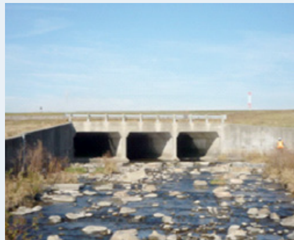
Figure 7 : Dalot triple du ruisseau Spring À l'aéroport de Pearson . (Source: Toronto Pearson - Dalot du ruisseau printemps, 2010 - Photo prise par Morrison Hershfield Limited et gracieusement fournie par la L'Autorité aéroportuaire du Grand Toronto)
