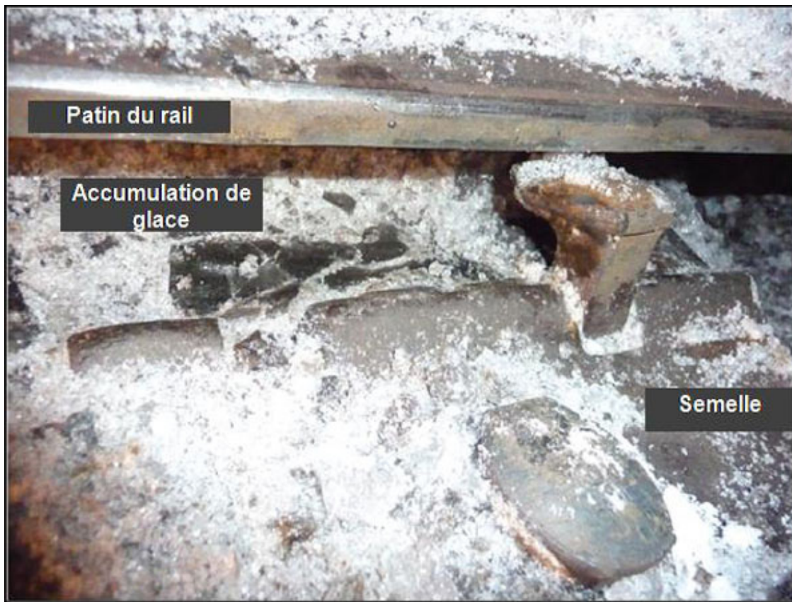
Figure 15 : Portion de la voie ferrée à Fernie, en Colombie-Britannique, montrant l'accumulation de glace. (Source : Bureau de la sécurité des transports du Canada)
