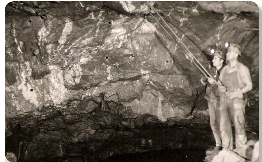
Filons de quartz aurifère (blanc) exposés sous la mine Dome en 1936. Photo reproduite avec la permission de la Collection du Musée de Timmins.
