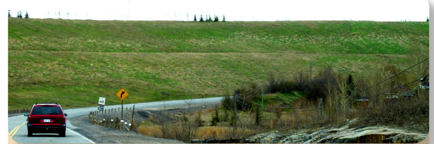
Vue 6 : Pentes restaurées de piles de résidus s'élevant au-dessus de la promenade Big Nickel Mine (route régionale 34) juste au nord de Terre dynamique.
