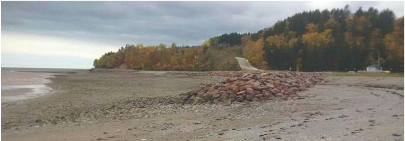
Figure 1.4 : Revêtement de roches, combiné à des ouvertures sur la plage, utilisé pour protéger le remblai de l'autoroute à l'entrée du parc national Fundy à Alma, au Nouveau-Brunswick, à marée basse. Photo reproduite avec l'aimable autorisation de Doug Watson, Parcs Canada.
