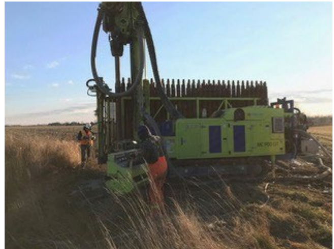
Figure 20 : Installation de puits non conventionnel
