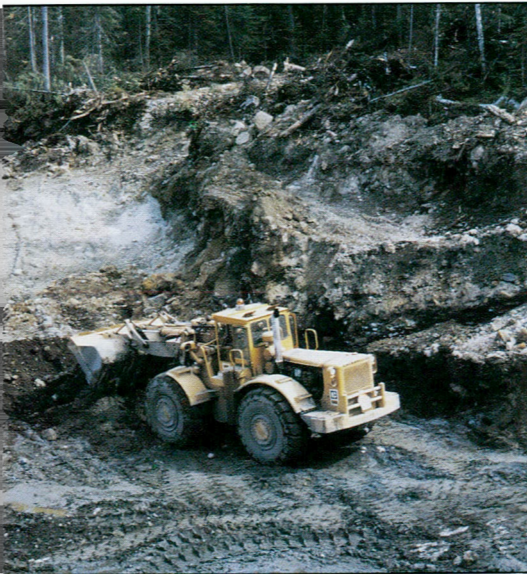
Figure 5 Coupe longitudinale dans la traînée de dispersion de l'Icon montrant le till de teinte foncée, riche en cuivre, qui s'élève au-dessus des sables de teinte pâle. Le déplacement des glaces se fait vers la gauche. Photo n° 203518 de la CGC.
