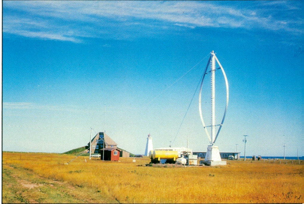
Banc d'essai d'énergie produite par une éolienne et un moteur diesel au site de vérification de la recherche sur l'énergie éolienne de l'Atlantique à l'Î.P.-E.
