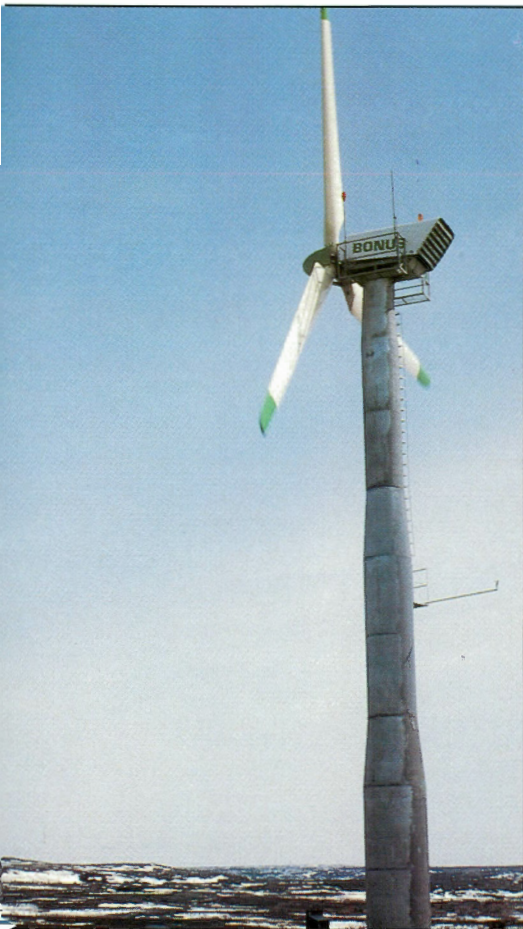
Une turbine éolienne à axe horizontal d'une capacité de 65 kw fournit l'électricité au village de Kuujuaq, au Québec.
