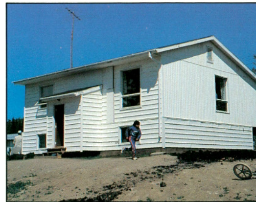
Figure 5 La maison unifamiliale est le genre d'habitation le plus courant dans bon nombre de collectivités amérindiennes. Très éconergétique, cette maison avec entrée à mi-étage construite à God's Lake Narrows s'avère populaire dans le nord du Manitoba. La maison a été conçue en consultation avec les membres de la collectivité et construite par une équipe locale formée d'autochtones.
