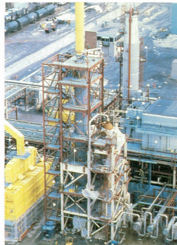
Figure 4 L'installation de la section du réacteur est complétée.
