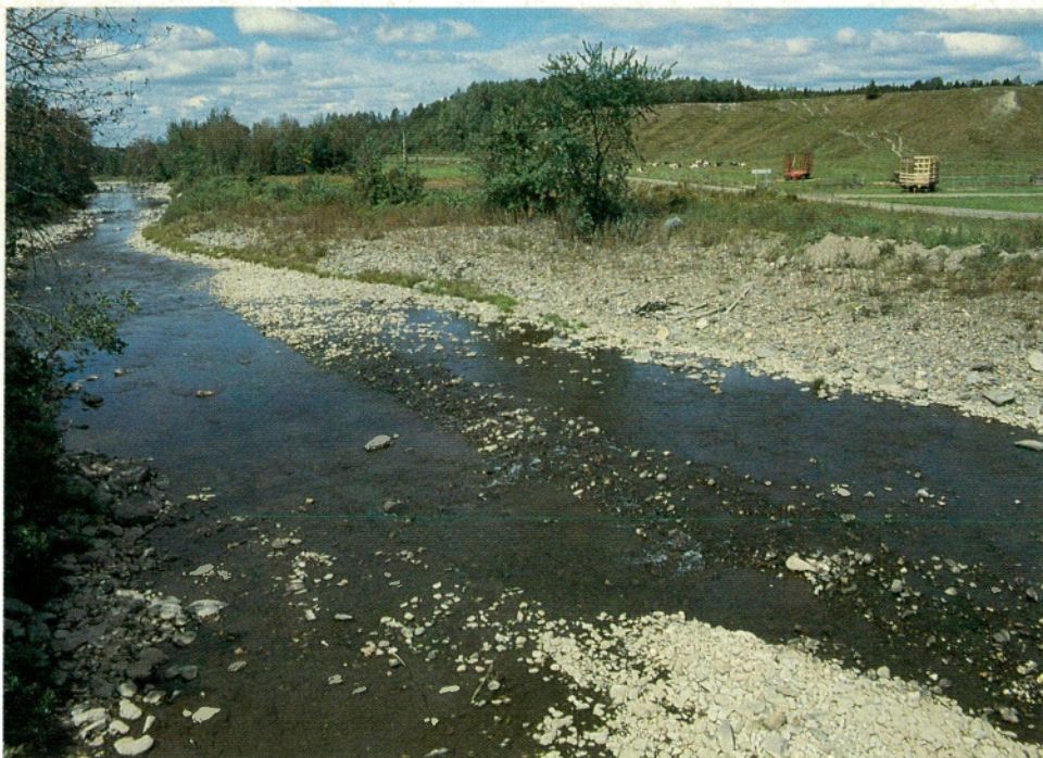
Figure 7 Lit majeur de la rivière Ascot occupé par l'homme. Au loin, on peut voir l'ancienne terrasse, témoin de l'évolution de la vallée fluviale. La ligne de rivage se situe au niveau de l'arbre isolé.
