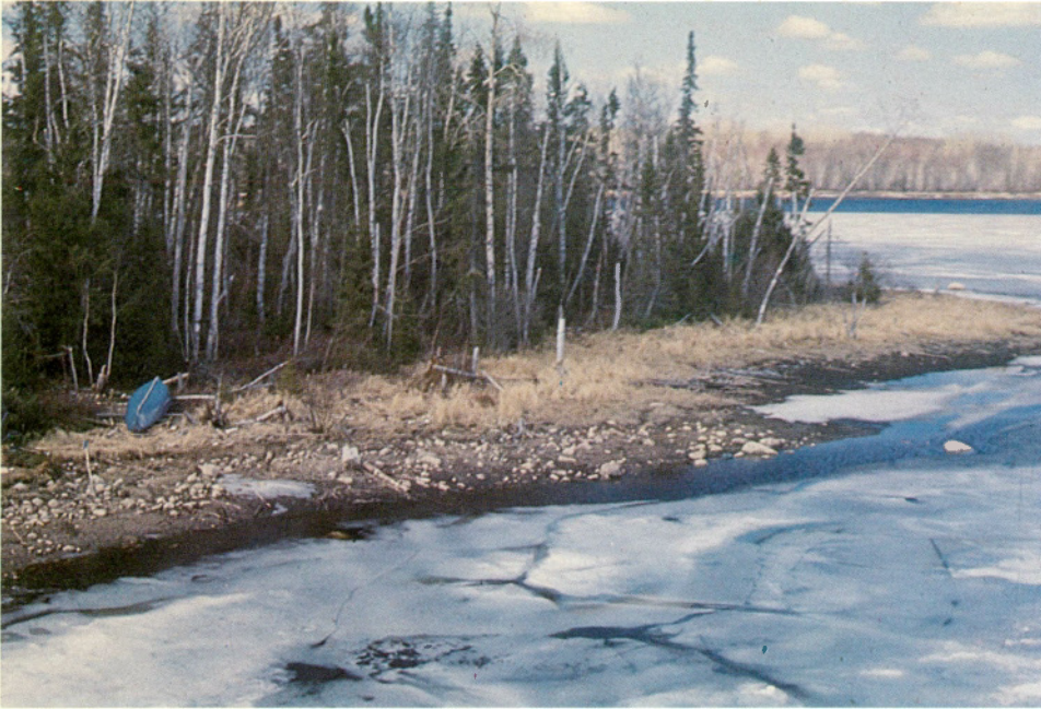
Stabilisation à long terme des berges. Réservoir Gouin, mai 1976 Long term slope stabilization in Gouin reservoir. May 1976
