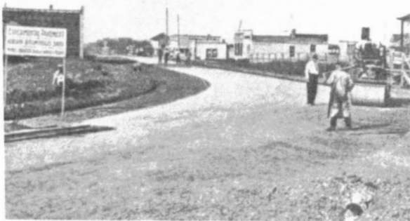
Revêtement de sable bitumineux posé par Ells à Edmonton, 1915
