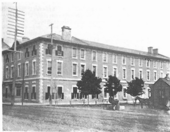
Nouveaux quartiers généraux de la Direction des Mines du Ministère des Mines au coin des rues Sussex et George à Ottawa
