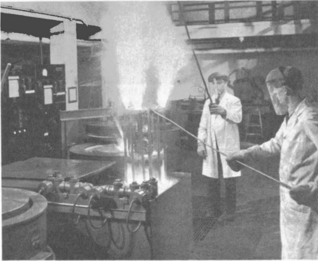
H. Fairfield et J. Kosowan effectuant la trempe à bain d'huile de tiges de forage en acier à 1550°F (Photo - ONF)
