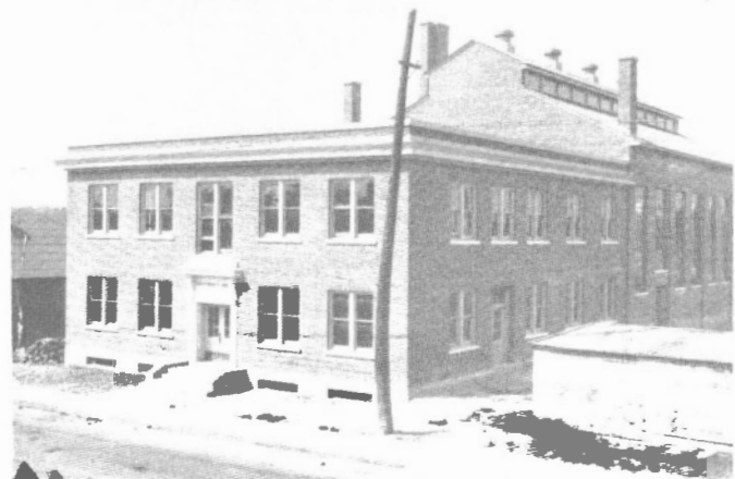
3. Les laboratoires de recherche sur les combustibles du Ministère des Mines au 562 rue Booth, avant la construction du troisième étage
