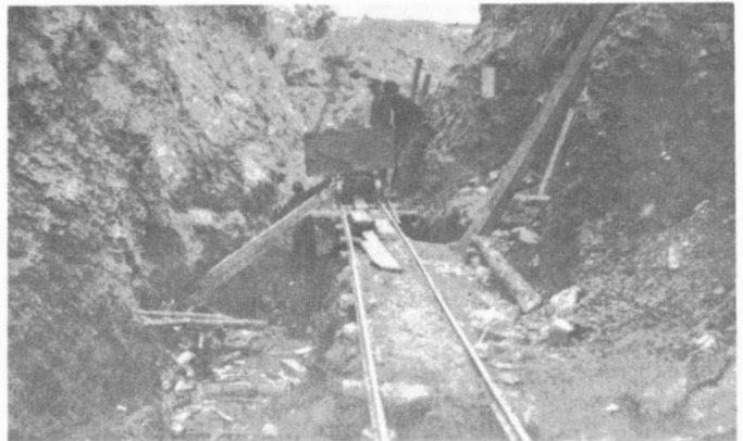
Minerai déversé d'une tranchée ouverte dans une gouttière, mine Lone Star Yukon
