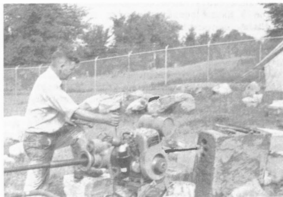
L. Richards perce des échantillons rocheux à Uplands, dans le cadre de la recherche sur le perçement au jet.
