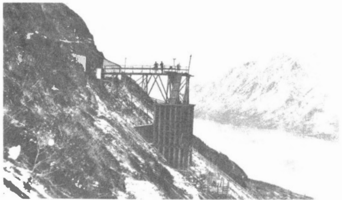
Entrée principale et poche de minerai de la mine Venus, au Yukon
