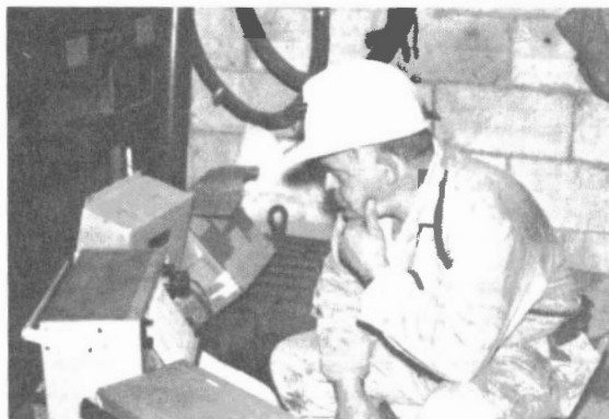
H. Poliquin surveillant une foreuse de puits vertical
