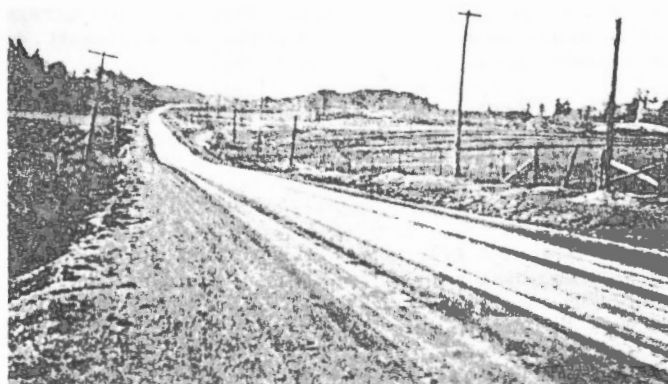
Route traitée au chlorure de sodium à l'est de Port Carling, Ontario
