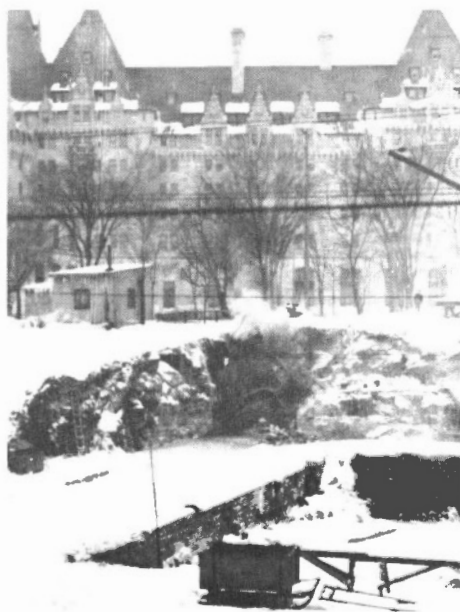
Construction de l'annexe du bâtiment de la Direction des Mines, rue Sussex
