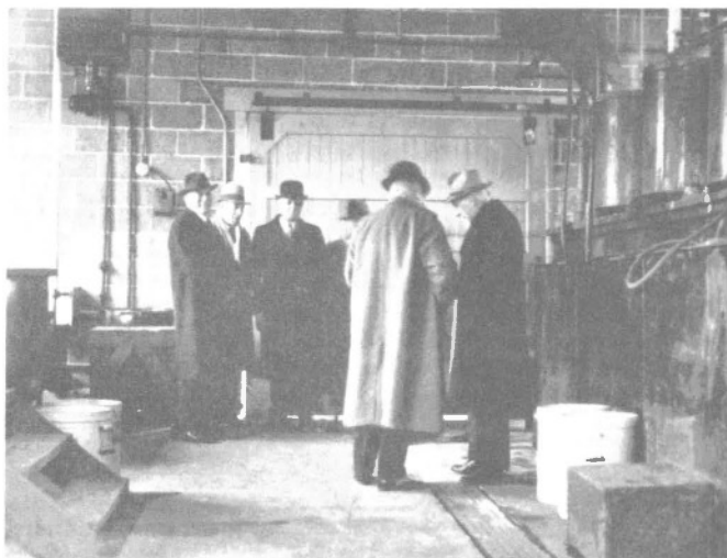
Visite de membres du personnel de la Direction des Mines à la raffinerie de Port Hope; (de gauche à droite: F.D. Reid, W.B. Timm, G. Labine; vus de dos, J.A. Faulkner, Sir F. Banting (Archives publiques du Canada))
