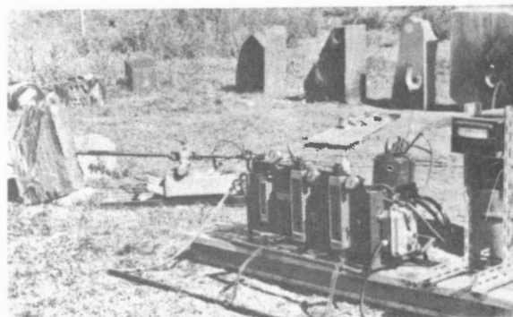
Équipement de perçement au jet; premier plan, pompe électrique et mesureurs de débit; centre gauche, torche à alimentation automatique.
