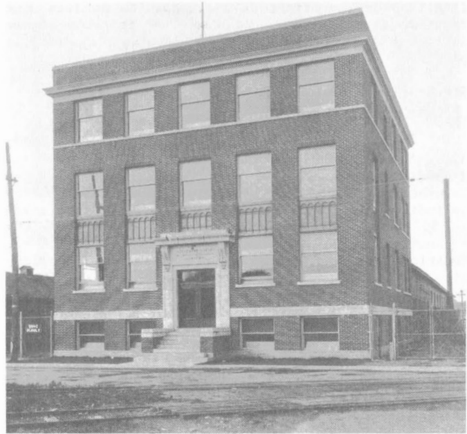
2. Les laboratoires de préparation des minerais et de métallurgie au 552 rue Booth (à l'emplacement de l'ancien édifice Peat).
