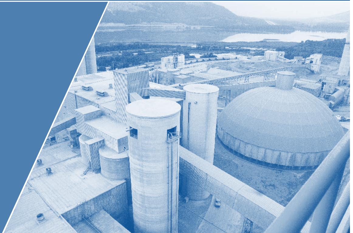
Usine Lafarge d'Exshaw, Alberta
