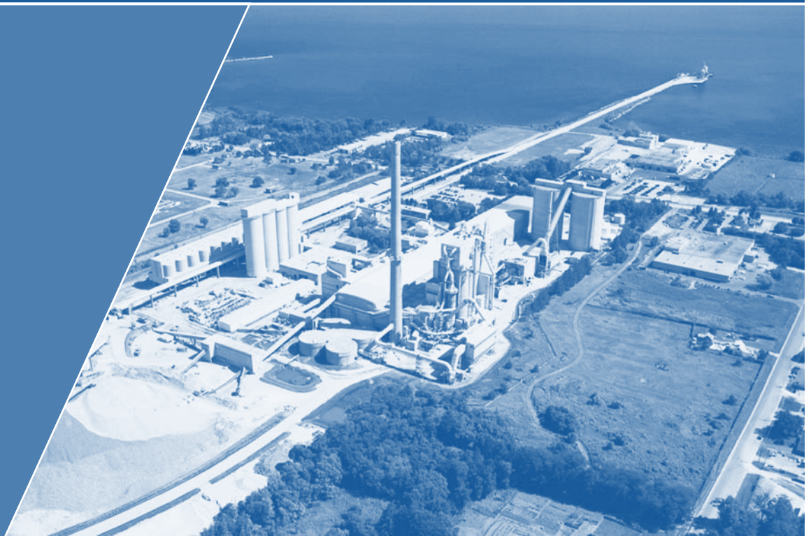
Usine Holcim de Mississauga, Ontario
