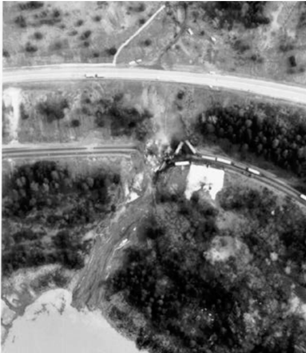
Figure 13 : Déraillement de train à Conrad, en Colombie-Britannique. L'affaissement du remblai a été causé par un événement de précipitation extrême. (Source : Bureau de la sécurité des transports du Canada)
