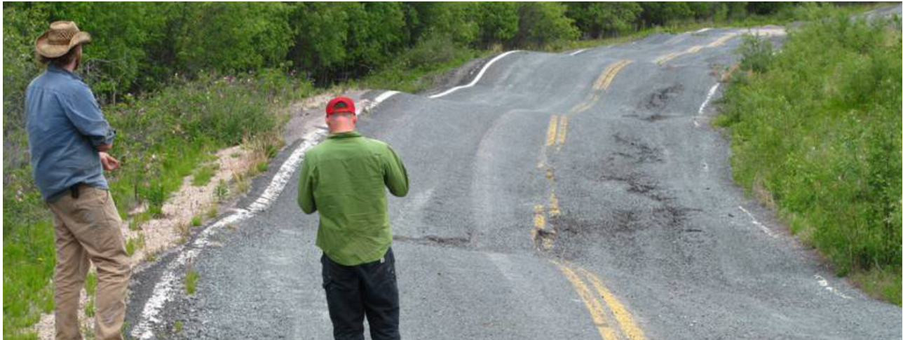
Figure 7: Tassement différentiel lié au dégel du pergélisol le long d'une section abandonnée de l'autoroute 4 dans les Territoires du Nord-Ouest, à l'est de Yellowknife. (Source : Ressources naturelles Canada)
