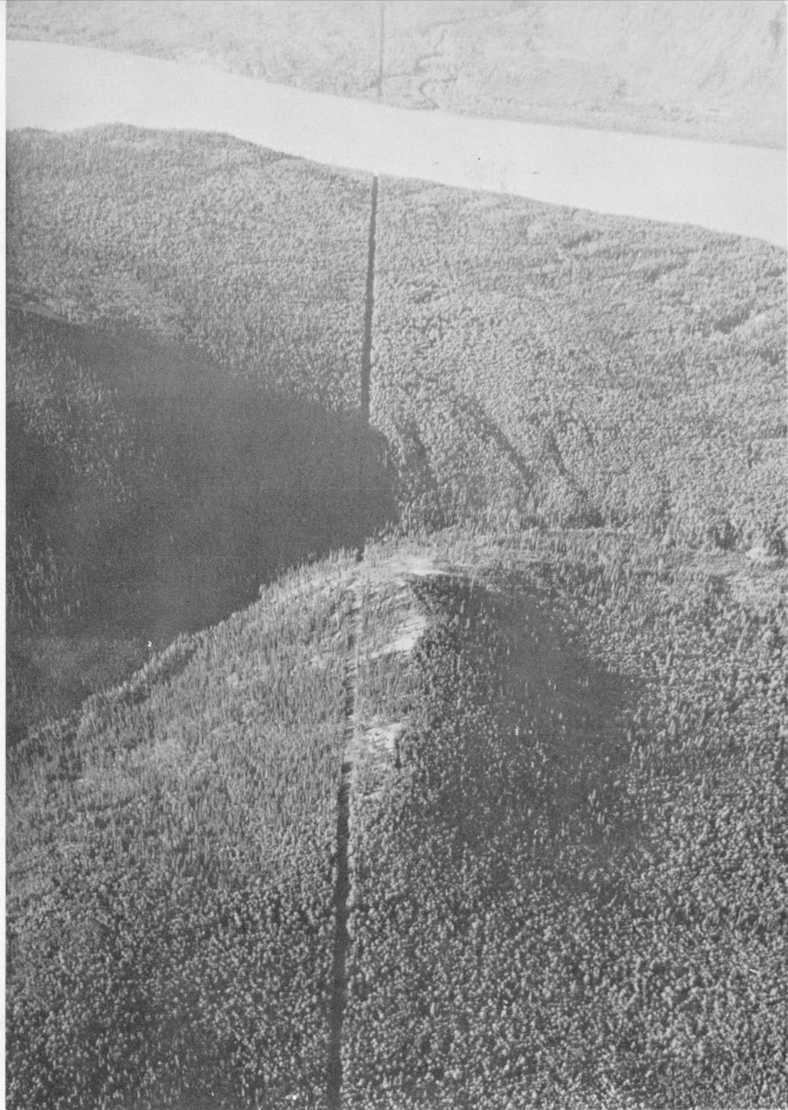
Photo aérienne montrant l'éclaircie le long du 141 e méridien, qui sert de frontière entre le Canada et l'Alaska, au point où la frontière traverse le fleuve Yukon. Les éclaircies sont entretenues par la Commission de la frontière internationale. (Commission de la frontière internationale)
