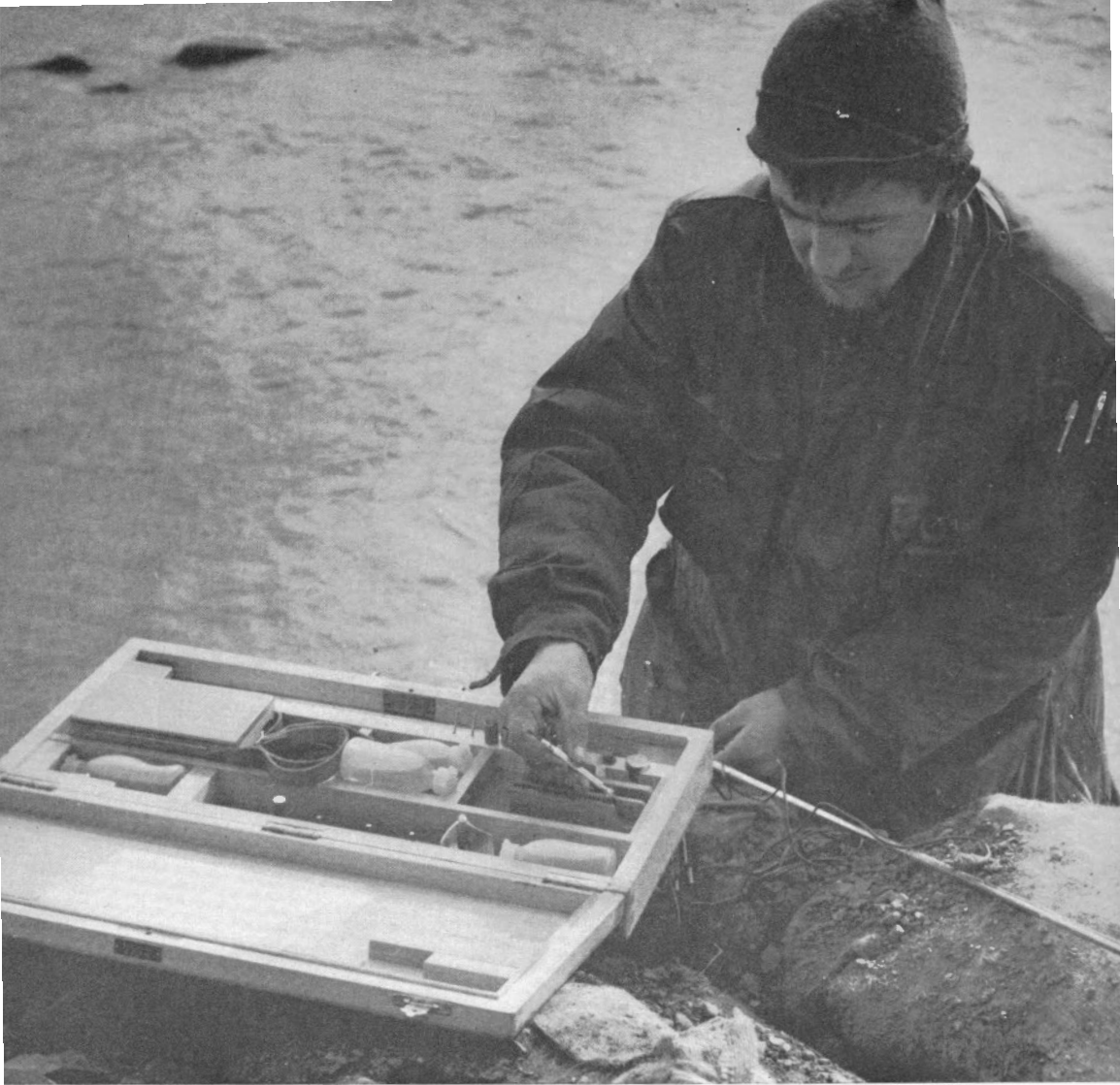
Géographe en train de mettre en place un appareil pour mesurer le courant d'un cours d'eau sur l'île Ellef Ringnes, à deux milles au nord d'Isachsen. Ce travail fait partie de l'étude de la sédimentation dans ce cours d'eau.
