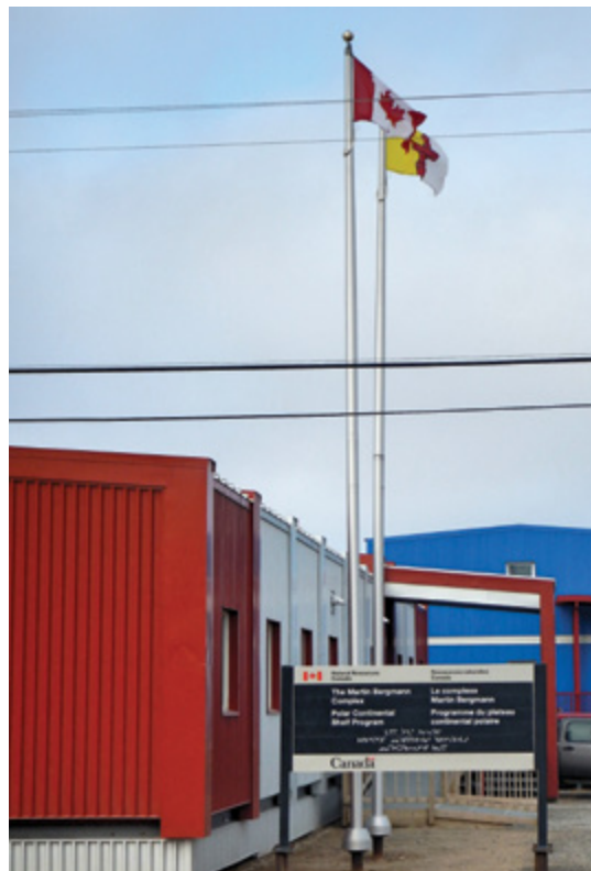
L'entrée principale au complexe Martin-Bergmann
