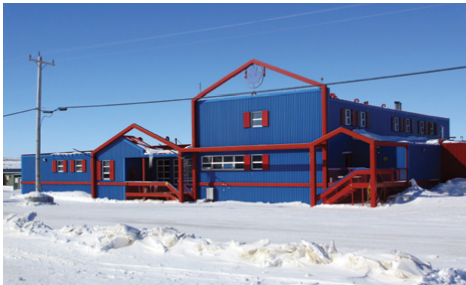
Un bâtiment d'hébergement au Centre d'activité logistique dans l'Arctique du PPCP
