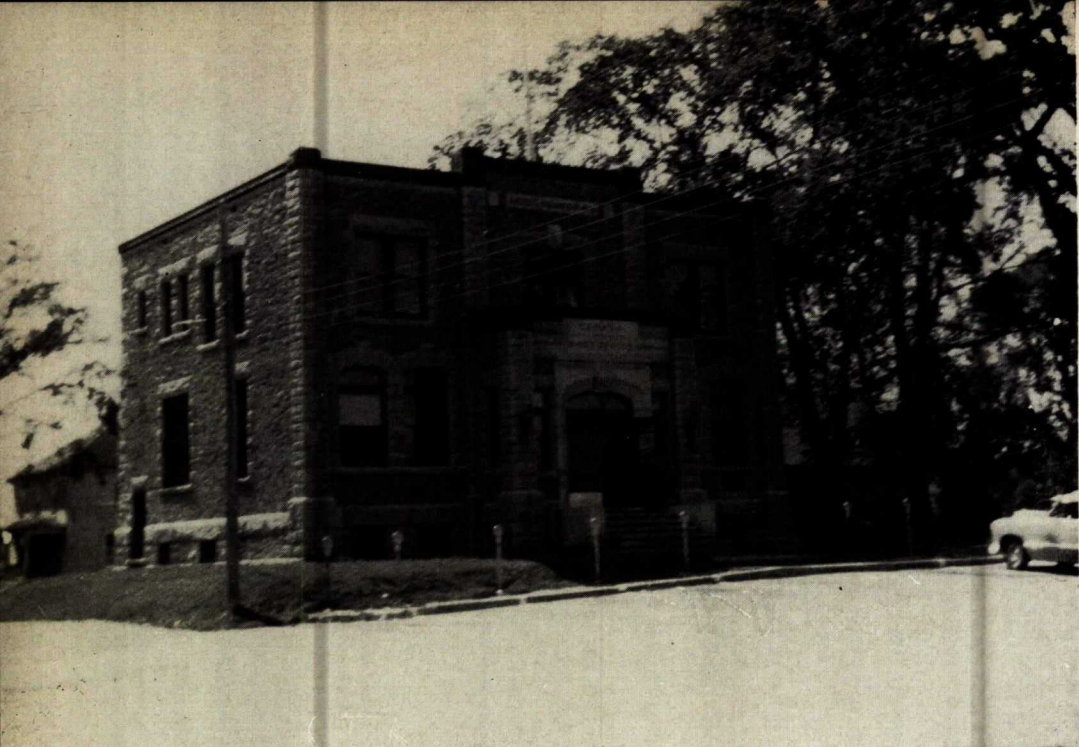
Figure 7 | Bureau de poste de St. George (N.-B.). Granit de St. George.
