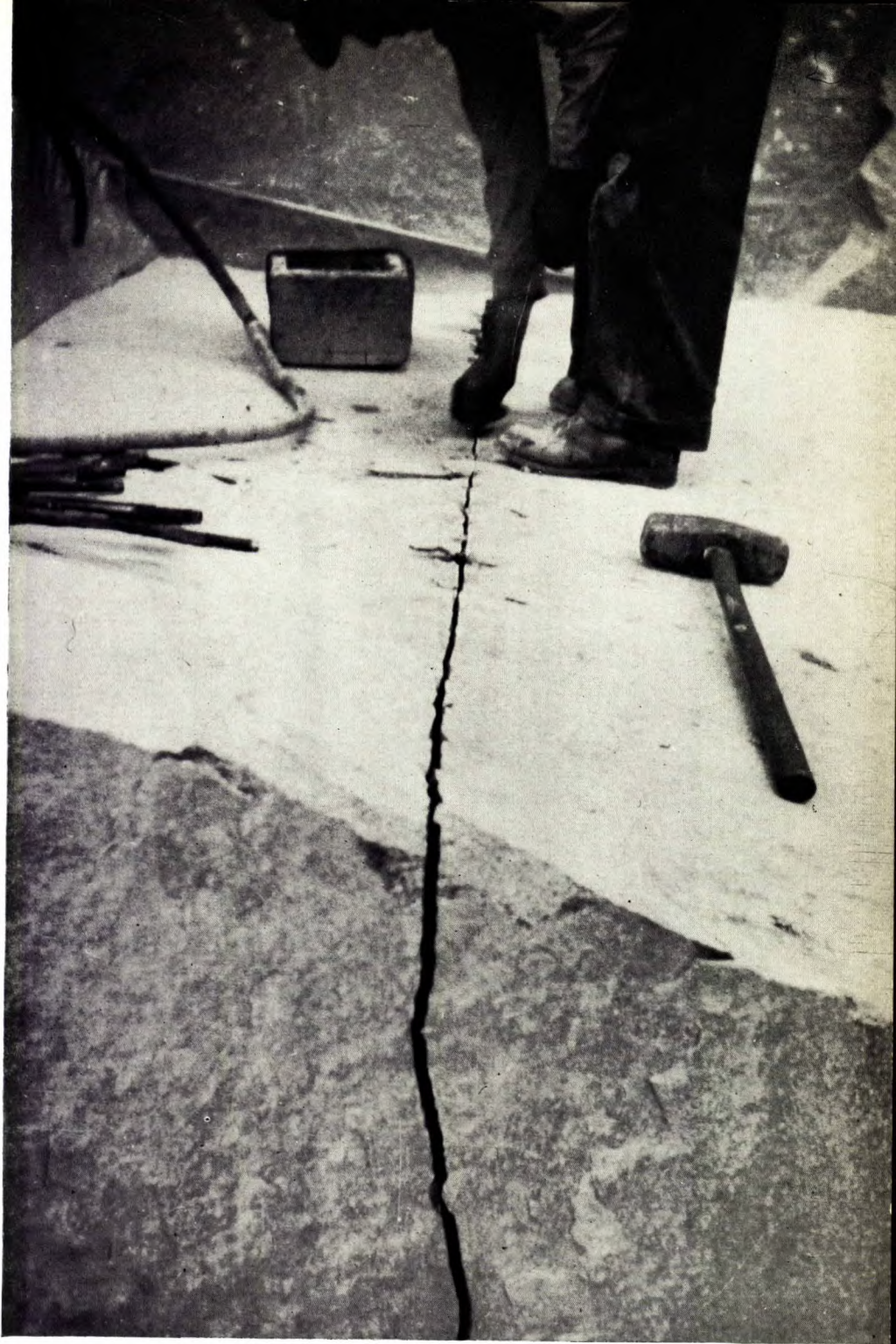
Figure 16 | Fendage du granit à l'aide de l'aiguille-coin à la carrière de l'Atlas Granite Company, Limited, région de Guénette (P.Q.).
