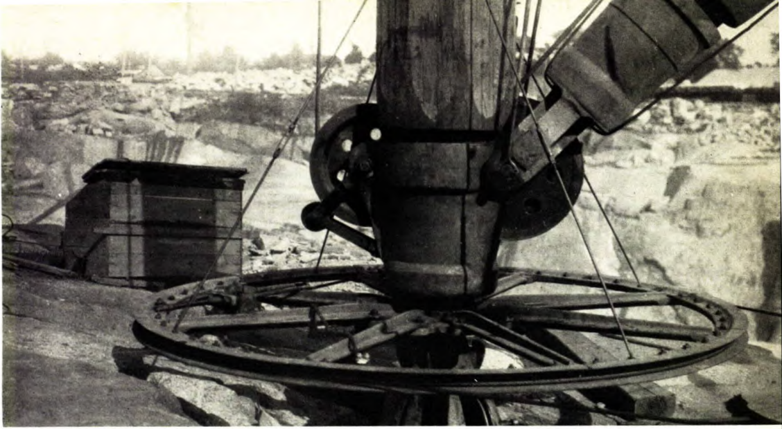
Figure 25 | Vue rapprochée de la base du grand derrick, à la carrière de la Brodie's Limited, Graniteville (P.Q.).
