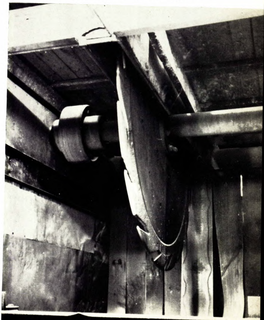
Figure 23 | Machine à surfacer les gros blocs de granit à l'atelier de taille de la Stanstead Granite Quarries Company, Limited, Beebe (P.Q.).
