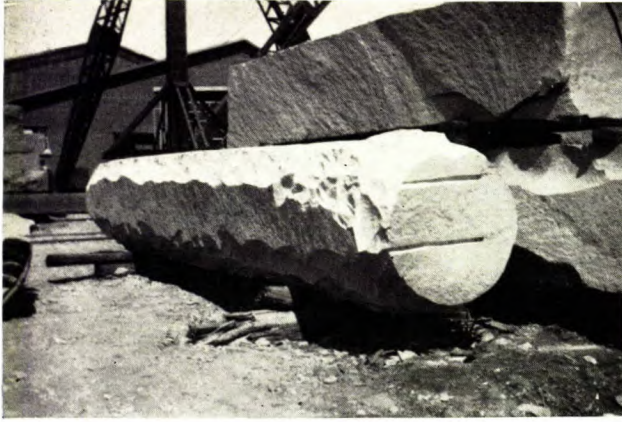
a) Blocs bruts, dégrossis à la main, dans le chantier de l'atelier à Iberville.
