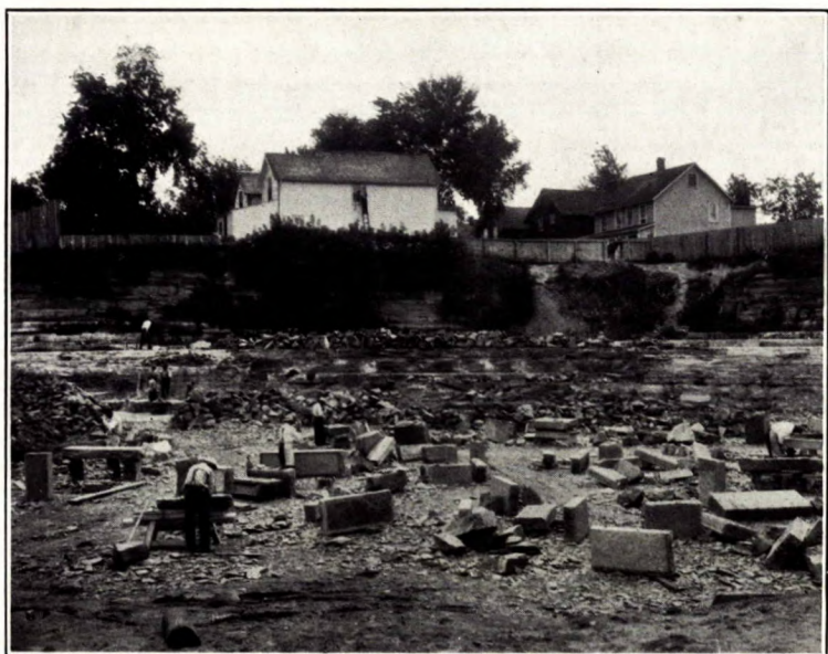
A. Taille du calcaire à la main, Kingston (Ontario). La pierre est taillée à la carrière même où elle a été extraite.
