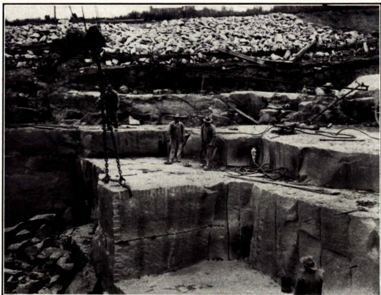
A. Une partie du front d'abatage, carrière de Queenston, montrant un bloc d'atelier détaché d'un banc de pierre et légèrement déplacé pour recevoir les crochets de la grue. A noter l'épaisse stratification.
