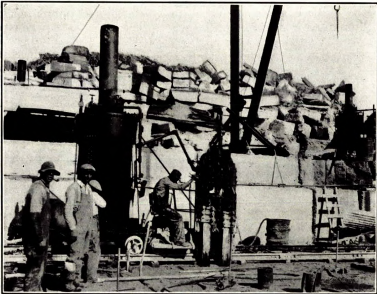
B. Trancheuse à vapeur duplex, carrière n° 2 de la Western Stone Company, Garson (Manitoba).
