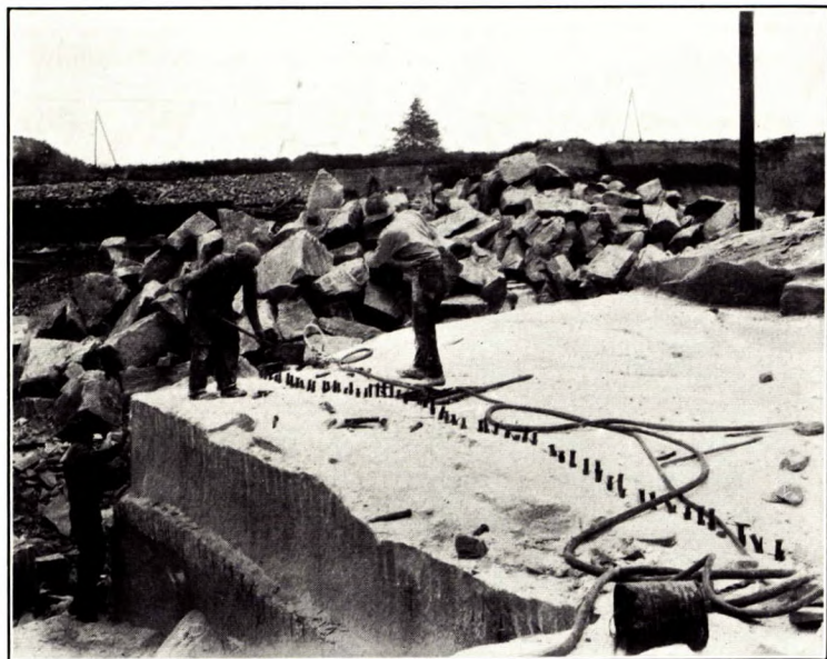
A. Méthode d'extraction au moyen d'aiguilles-coins. Carrière de Queenston, St. Davids (Ontario).
