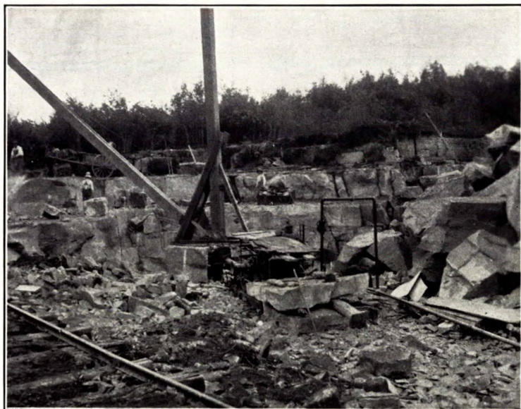
A. Carrière Stone & Quarry, Ltd., Saint-François-de-Sales (Québec).
