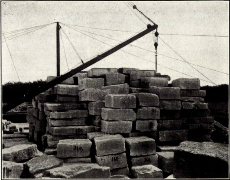
B. Tas de blocs d'ateliers à la carrière Gillis. Remarquer les lettres et chiffres apposés sur les blocs.
