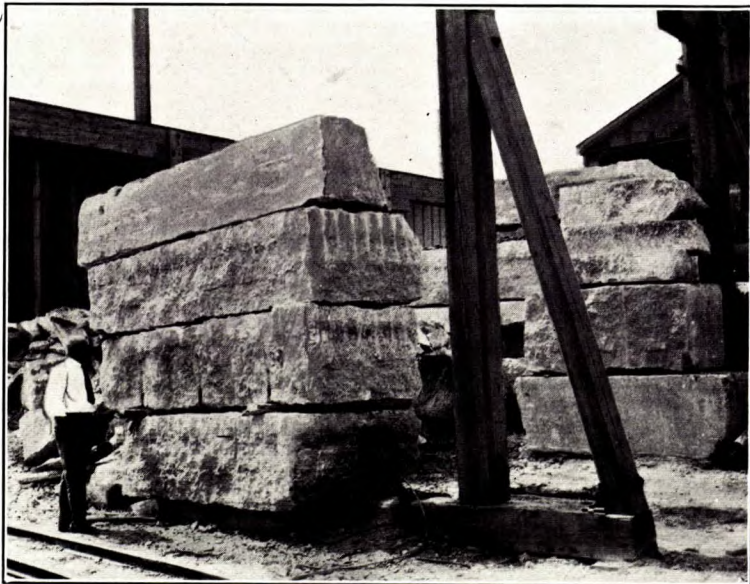
B. Blocs d'atelier au chantier de pierre de taille de la Tyndall Quarry Company à Winnipeg (Manitoba).
