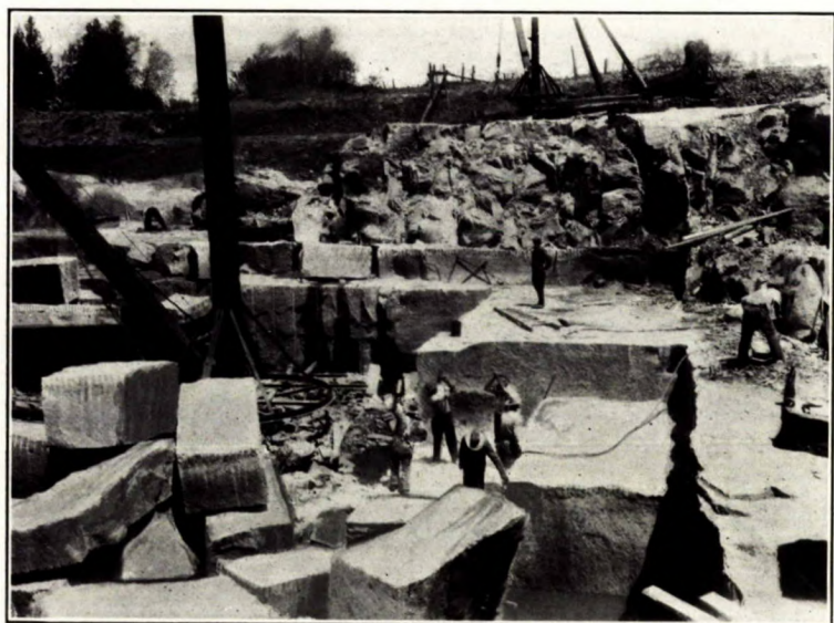
B. Un coin de la carrière de Queenston, montrant les couches épaisses de pierre de construction en dessous de la roche de qualité inférieure du sommet.
