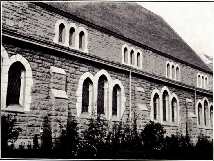
B. Église anglicane "All Saints", Winnipeg. Cette photographie fait ressortir le contraste entre la face naturelle et la face travaillée à la machine de la pierre calcaire de Tyndall.
