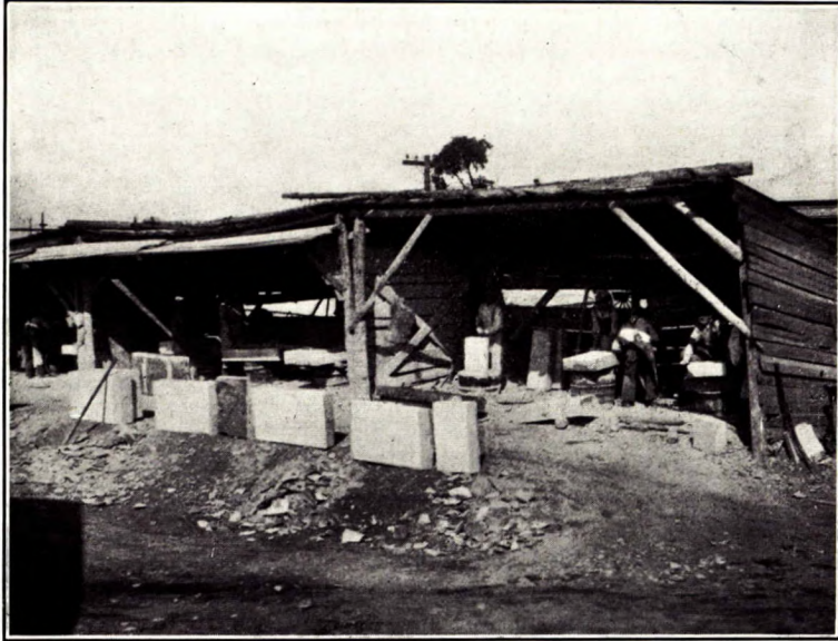
A. Dressage de la pierre à la main. Carrière Gauthier, Saint-Marc-des-Carières (Québec).
