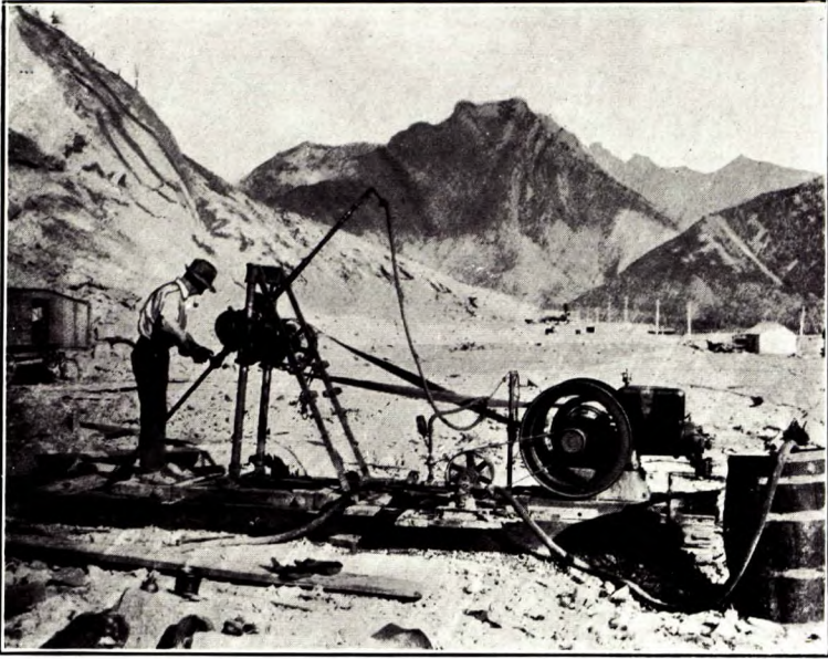
A. Perforatrice à diamants. Cet appareil convient pour le forage des trous de prospection.
