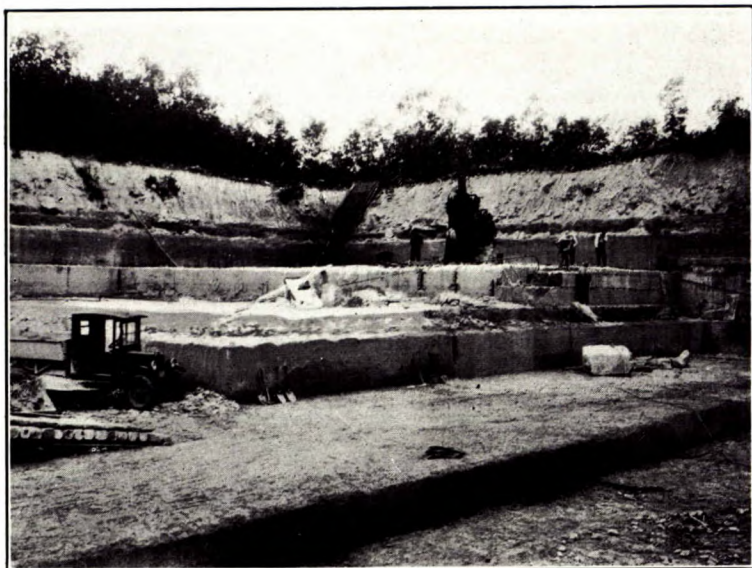
A. Une partie de la carrière Gillis, Garson (Manitoba). Des bandes découpées à la trancheuse sont soulevées par des coins.
