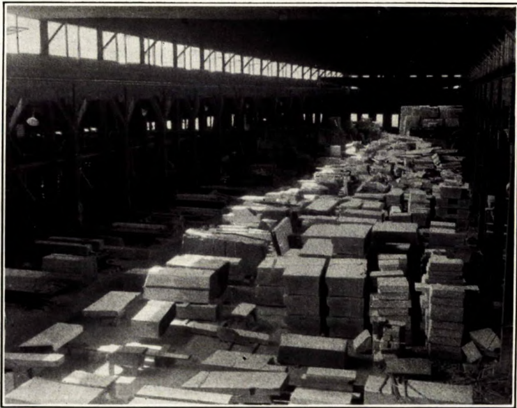
B. Intérieur d'un chantier de pierre de taille à Montréal. La partie centrale du chantier est occupée par des pierres à divers stades de la taille. Les machines à tailler la pierre sont rangées sur les côtés, de part et d'autre de la partie centrale.
