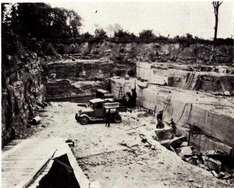
A. Calcaire de Chazy à strates épaisses extrait comme pierre de construction par Martineau Fils, Ltée, Village Bélanger, île Jésus.
