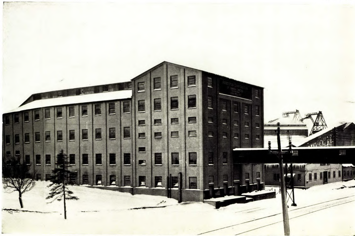
Mine King et atelier de traitement, Asbestos Corporation, Limited, Thetford-Mines (Québec).
