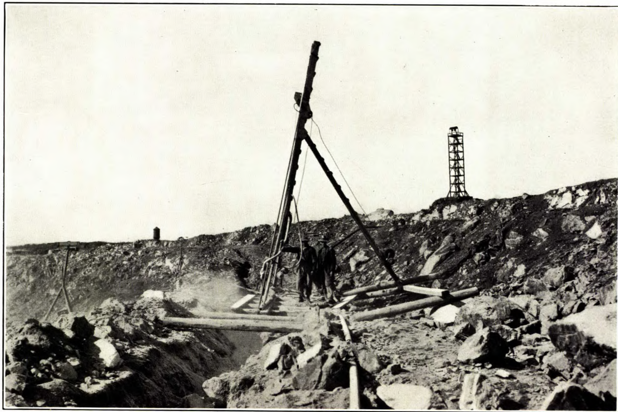
Perforatrice montée sur chevalement, Canadian Johns-Manville Company, Limited, Asbestos (Québec).
