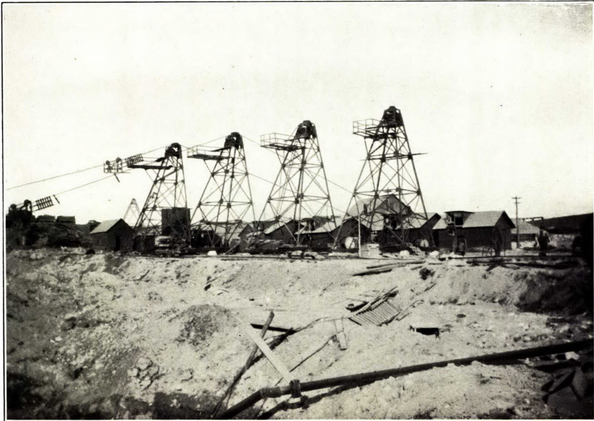
Pylônes de soutien, Johnson's Company, Thetford-Mines (Québec).
