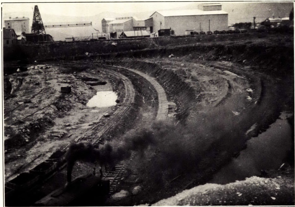
Pelle mécanique enlevant le mort-terrain, mine King, Asbestos Corporation, Limited, Thetford-Mines (Québec).
