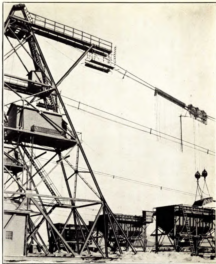
B. Pylônes de soutien et trémies à roches.
