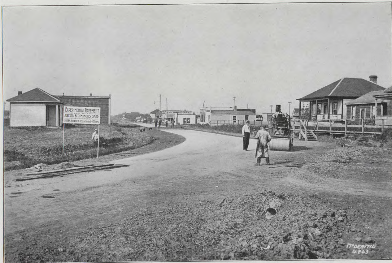
Pavage d'essai construit au moyen de sables bitumineux à Edmonton, Alberta.
