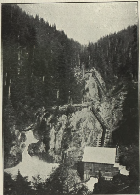
Usine motrice hydro-électrique pour extraction. Usine motrice n° 2. mine Premier, Stewart (C.-B.).
