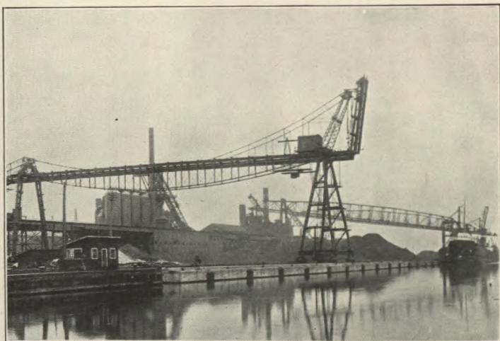
Dock de minerai de fer avec ponts de déchargement. Algoma Steel Corporation, Sault Ste-Marie (Ont.).
