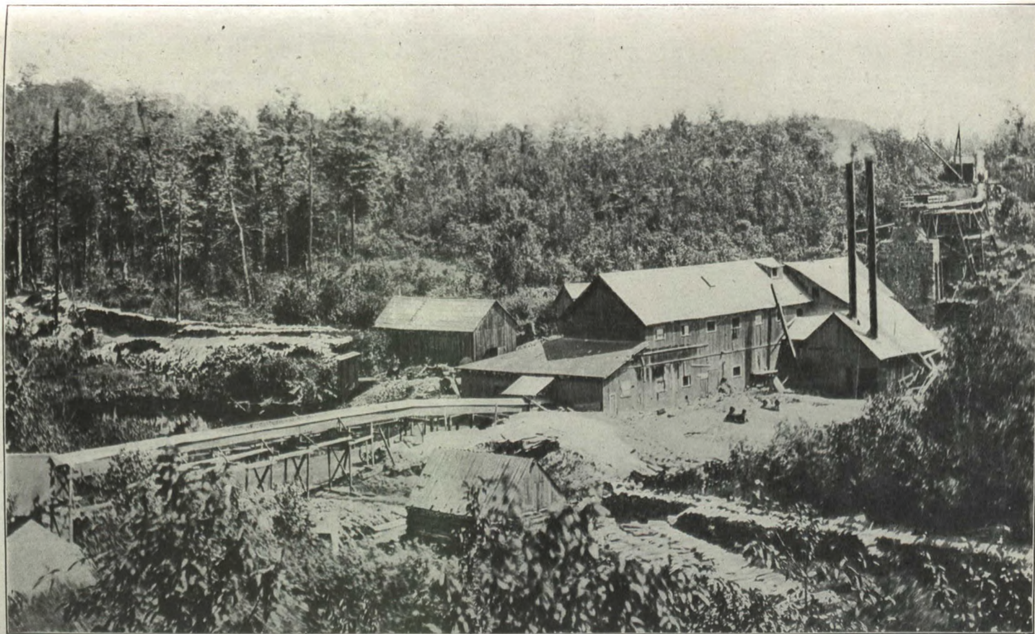
Usine de la Buckingham Graphite Company (North American Mine), canton de Buckingham, Qué. Cette photographie fut prise il y a quelques années et les bâtiments sont passablement délabrés. La direction du gîte est indiquée par le tramway et la galerie principale pénètre dans l'usine sur la gauche du four.
