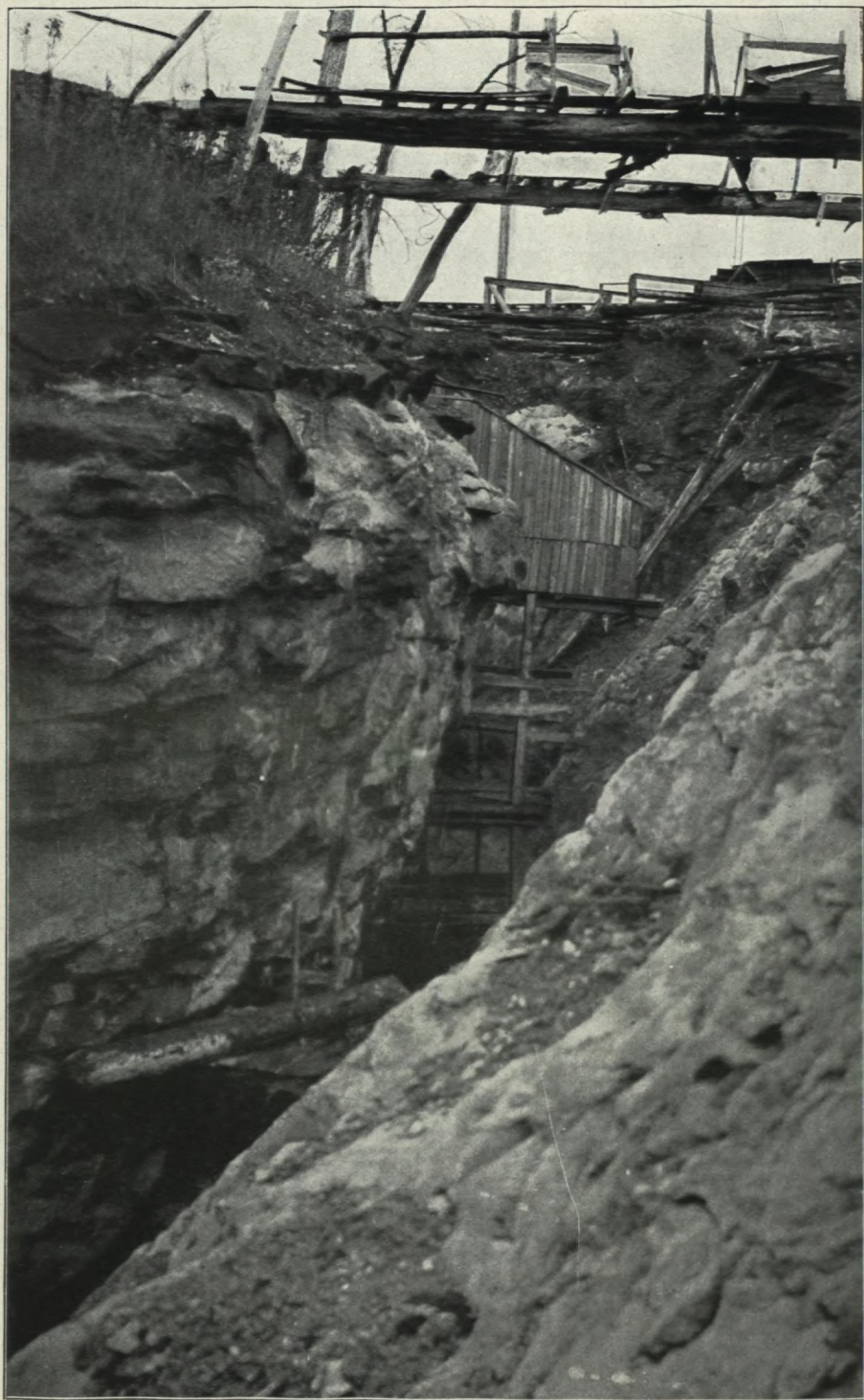
Méthode d'extraction dans le gîte calcaire graphitique, concession XIII, lot 23, canton de Montegale, Ont.
