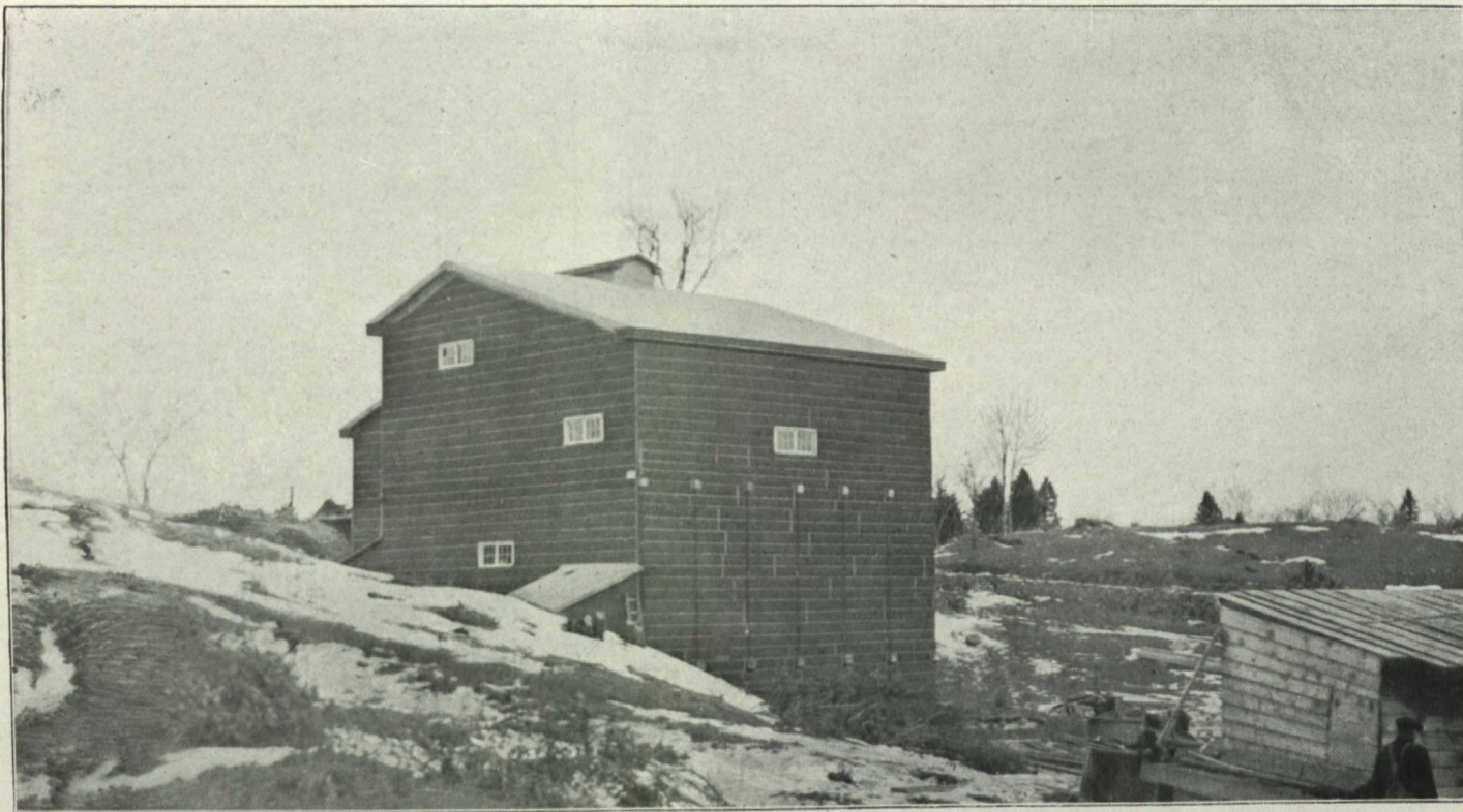
Usine sur la propriété Timmins, concession V, lot 25, canton de North Burgess, Ont.
