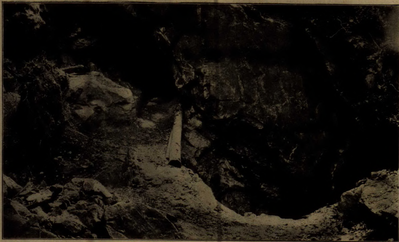
Galerie et puits sur un filon incliné, en forme de poche, de mica-apatite, rang III, lot 1, canton de Portland Est (Qué.). C'est une illustration de la façon dont se présentent et s'exploitent ordinairement ces filons.
