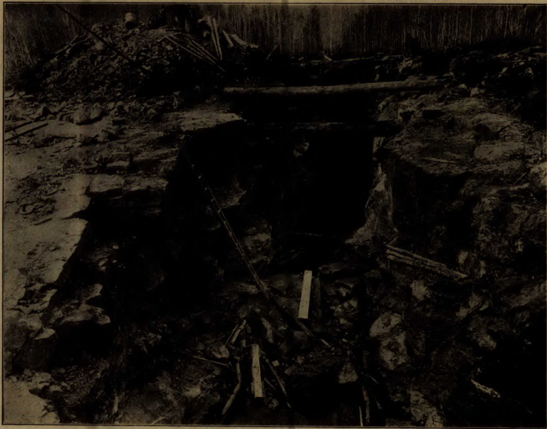
Tranchés dans un filon d'apatite, mine McCrae, canton de Templeton (Qué.). Méthode ordinaire d'exploitation des parties de phosphate et de mica qui se voient à la surface dans des filons verticaux.
