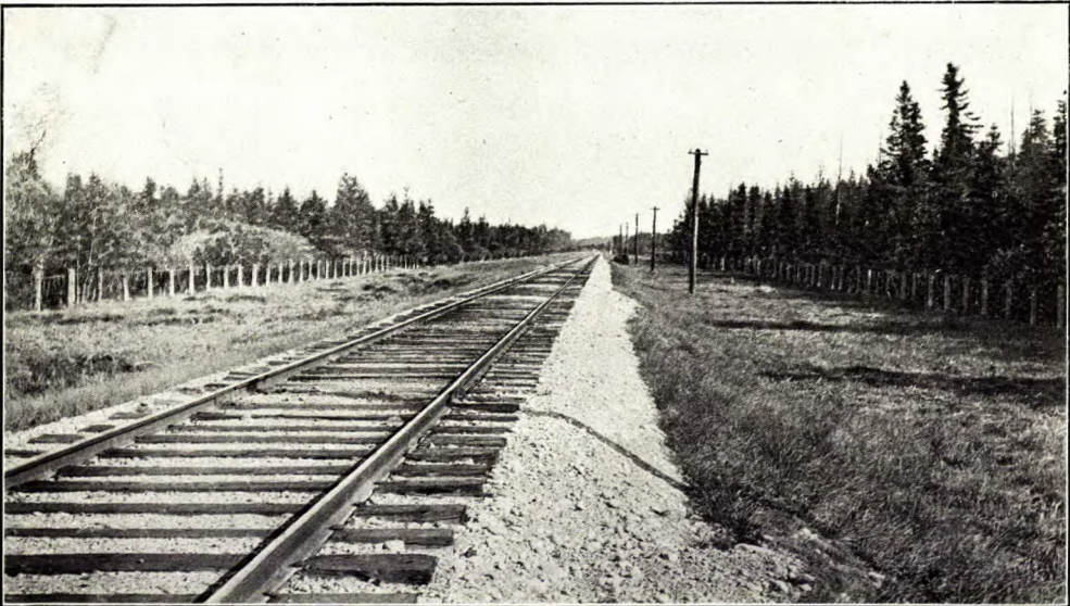
Passage à niveau du chemin de fer à la tourbière Marsh Hill, Ontario.
