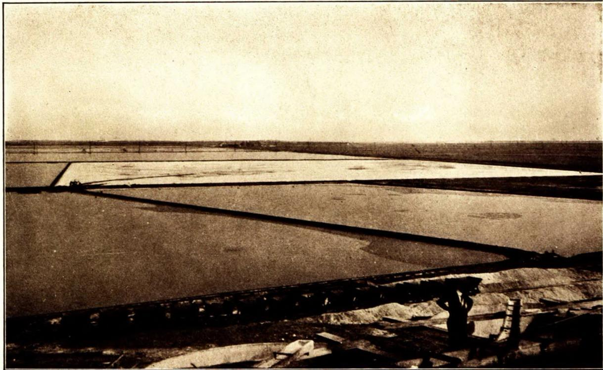
Vue d'un réservoir où on laisse le sel se cristalliser; on y voit un champ de sel prêt à être récolté, à la Leslie Salt Co., San Mateo, Californie.
