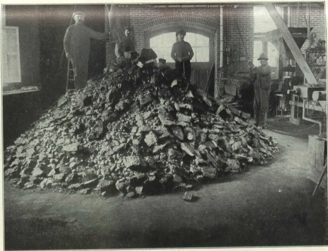
Echantillonnage—un cône de houille non-broyée.—Section des mines et de la préparation des minerais, Université McGill.
