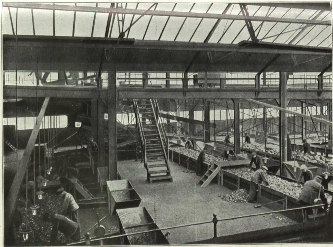
Cribles à secousses et courroies de triage, houillère de Manton, Angleterre.
