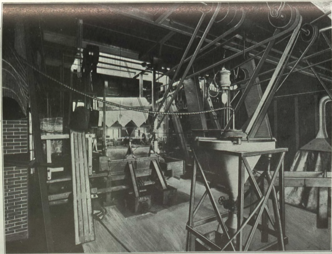
Cribles à révolutions, jig, laveur Robinson, etc.—Section des Mines et de la Préparation des Minerais, Université McGill.
