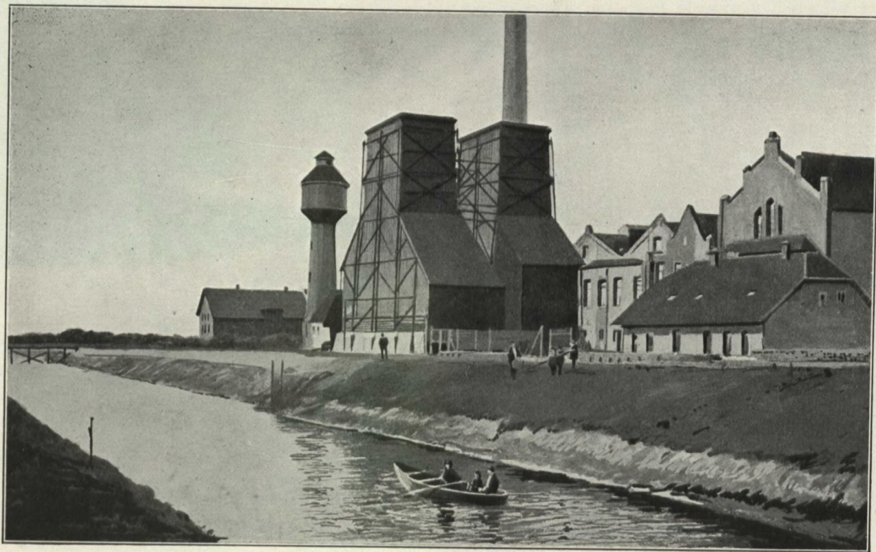
Partie terminée du canal passant devant l'usine d'énergie.
