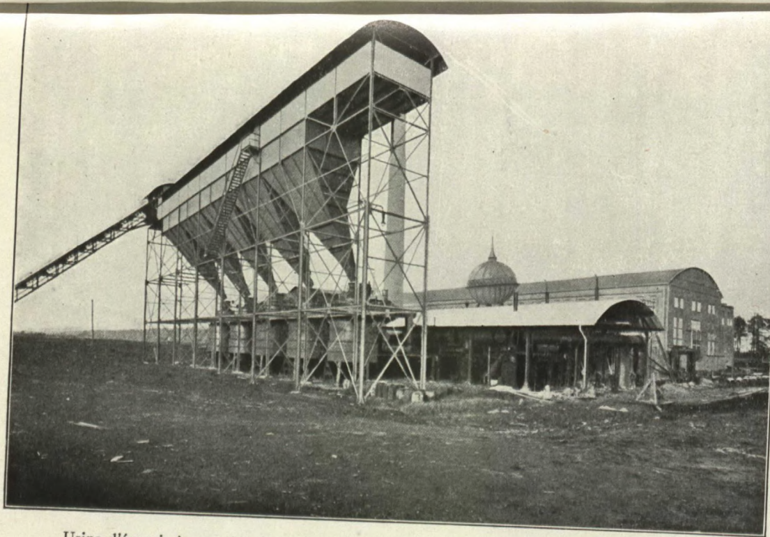
Usine d'énergie à gazogène à tourbe, avec récupération des sous-produits, 3,000 chevaux, tourbière de Schweger Moor; vue générale de l'usine.
