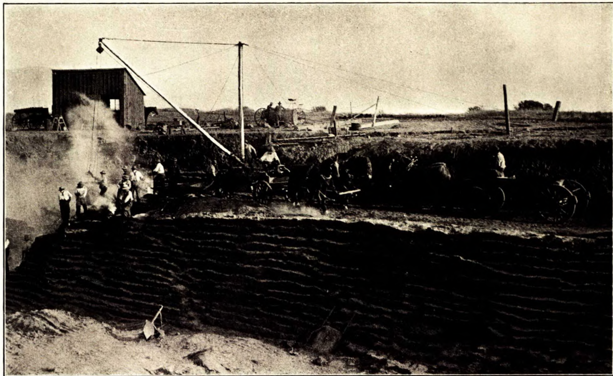
Carrière de sable bitumineux mou près de Carpinteria, Cal., E.U.A. Le sable bitumineux a 10 à 15 pieds d'épaisseur et est recouvert de 8 à 10 pieds de terre. Il faut une série d'opérations pour creuser le sable bitumineux et on emploie à cette fin des bèches chauffées.
