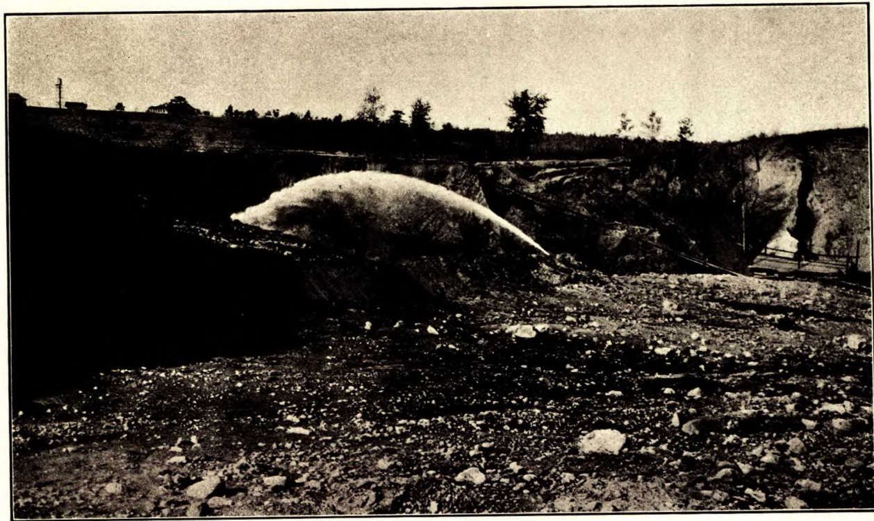
Mine Rowe, Minnesota. Vue générale, montrant l'enlèvement hydraulique du manteau stérile, tuyau d'alimentation d'eau, tuyau de décharge, et canon hydraulique.
