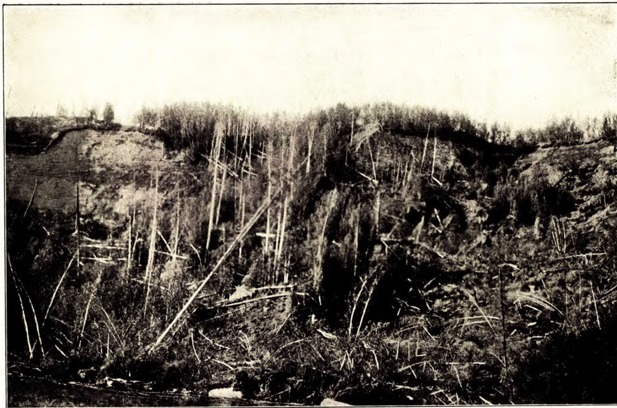
Exemple type d'un éboulement argileux. De tels éboulements sont communs le long des cours d'eau où le manteau stérile au-dessus du sable bitumineux est épais.
