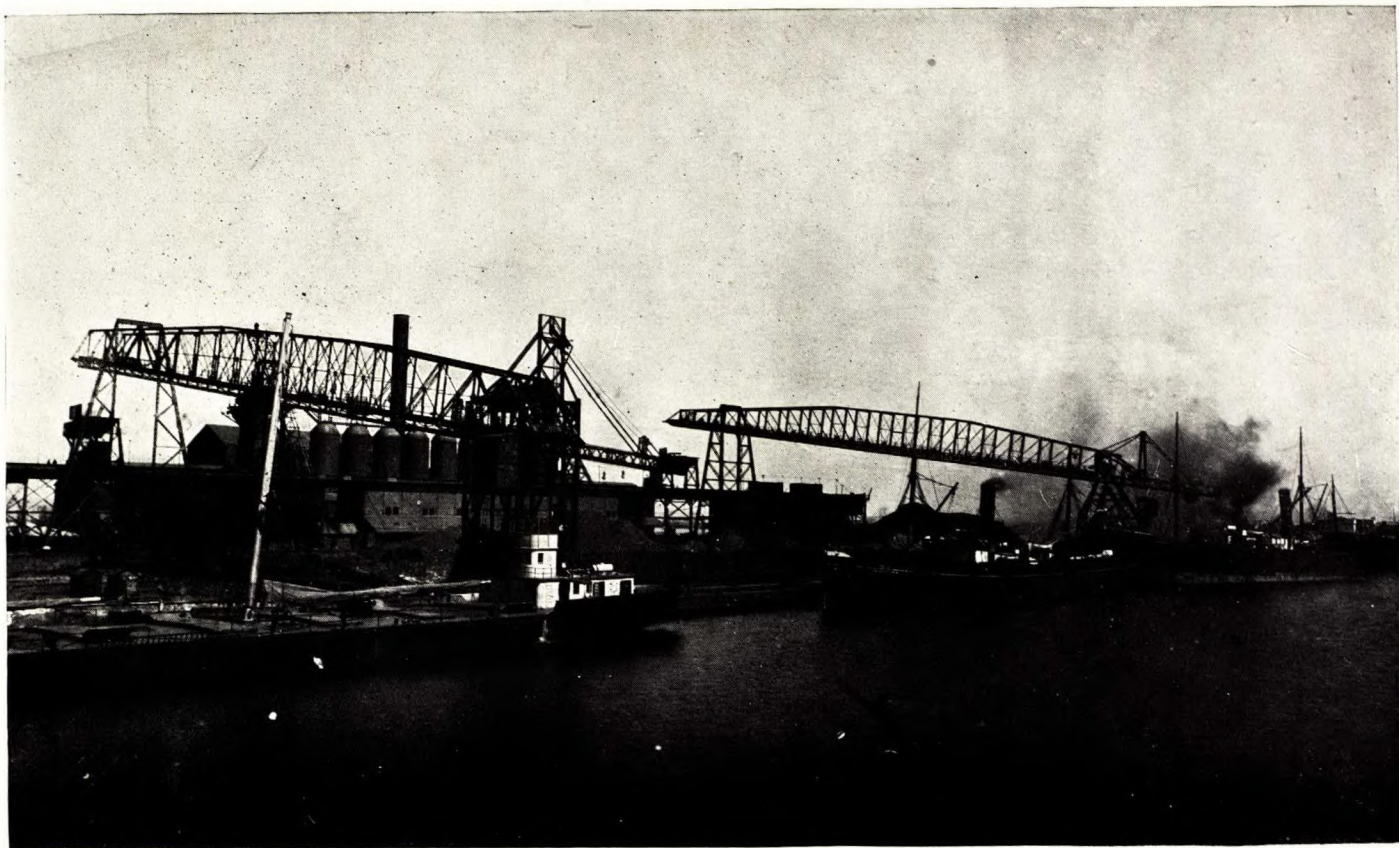
Haut fourneau et bassin d'arrivée des minerais, Sault Ste-Marie, Ont.
