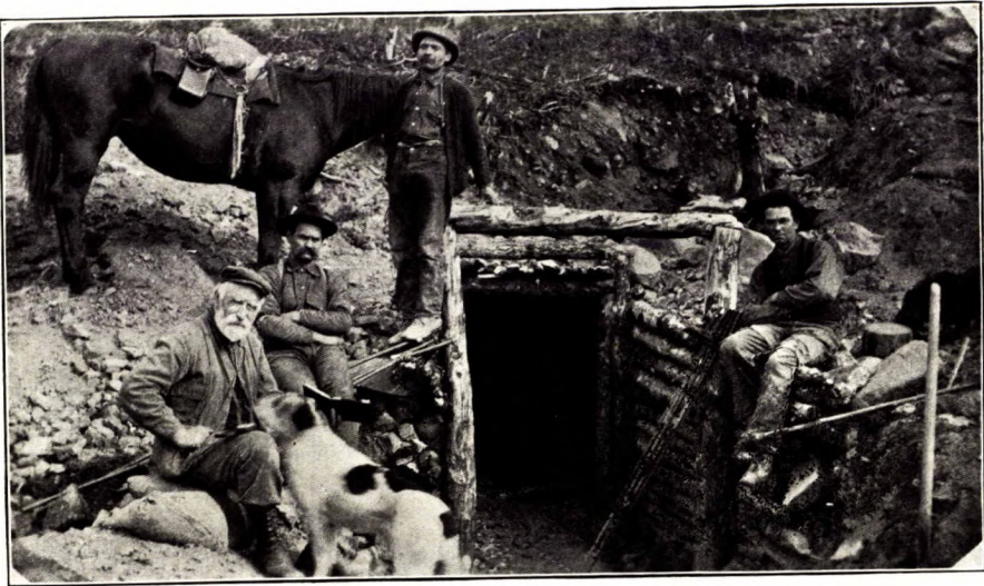
Entrée du tunnel, claim minier Olive.
