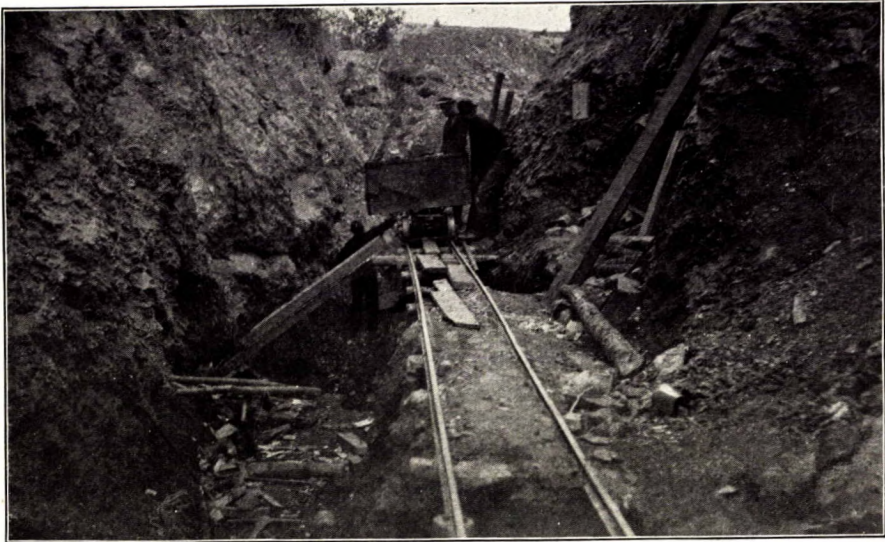
Jetant du minerai d'une tranchée à ciel-ouvert dans une chute, amené par un remontage d'un niveau inférieur, mine Lone Star.
