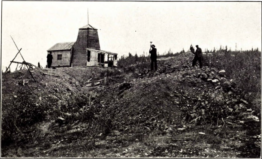
Echantillonnage d'une pile de quartz près du puits Violet, Eldorado, T.Y.
