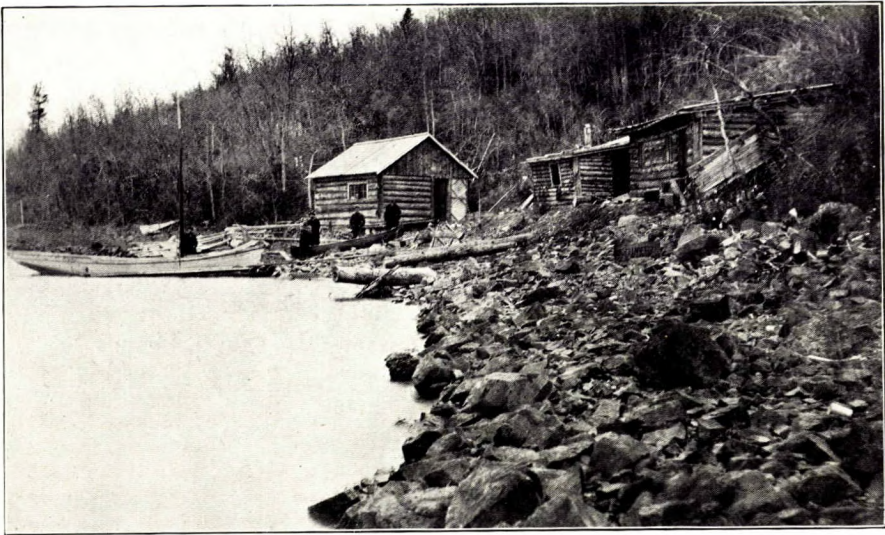
Bâtiments de Dail et Fleming sur le groupe Humper, au bord du Windy Arm.
