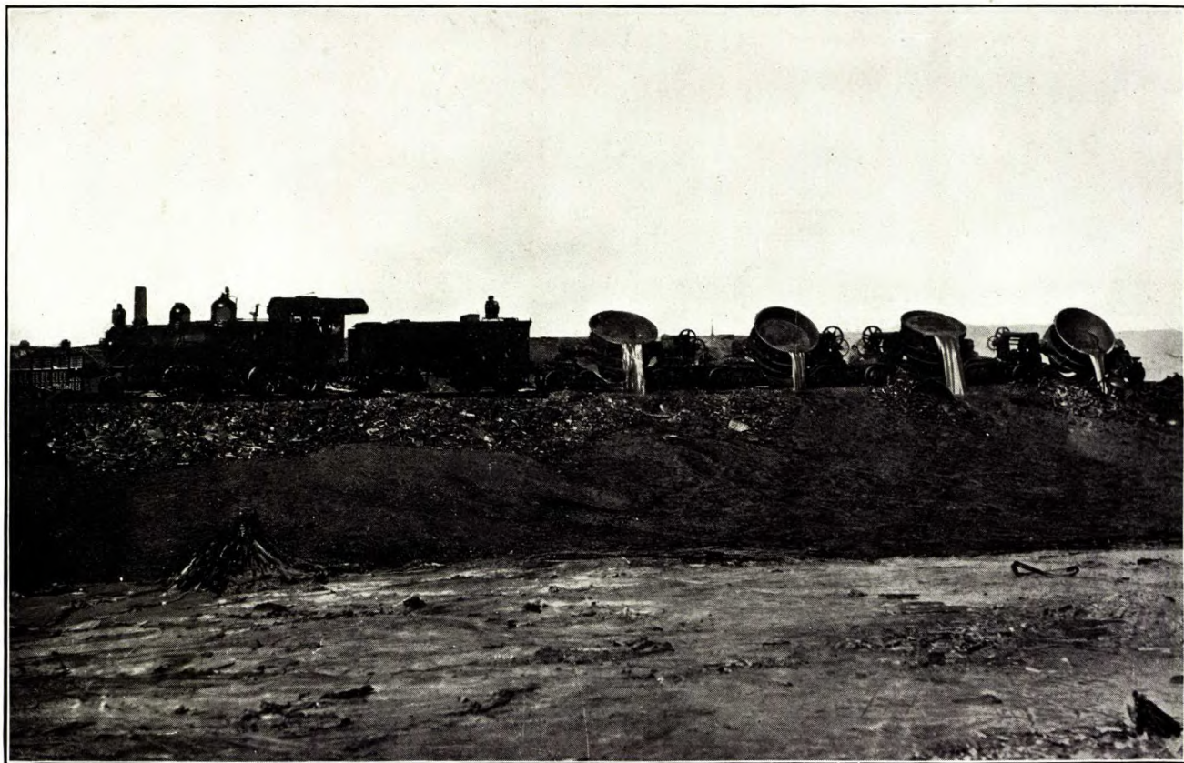
Coulée de la scorie, Canadian Copper Co., Copper Cliff, Ontario.
