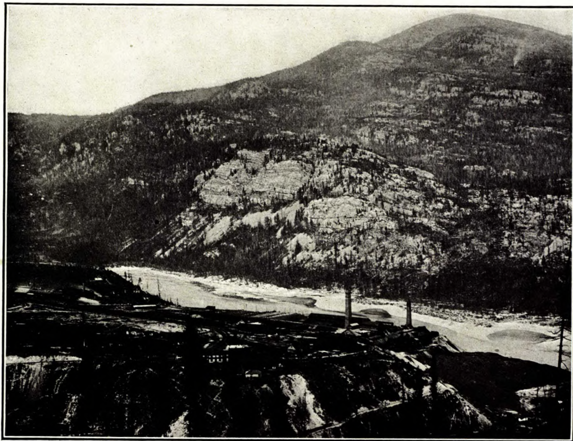
Vue d'ensemble de l'installation de Trail Consolidated Mining and Smelting Co. Trail, Colombie britannique. (Photo. par J. M. Turnbull, Trail).
