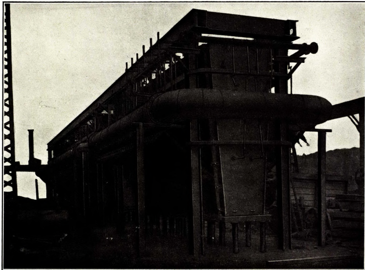
Nouveau fourneaux pour l'installation d'Anyox, Granby Consolidated Mining & Smelting Co., Anyox, C.B. (Traylor, Eng. & Mfg. Co.)
