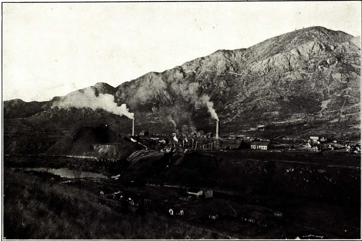
Vue d'ensemble de la fonderie de Granby, Granby Mining & Smelting Co., Grand Forks, C.B
