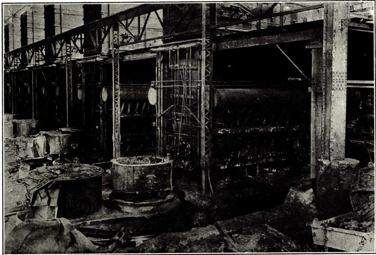
Intérieur des dépendances des hauts fourneaux, fonderie de Granby, Grand Forks, C.B.
