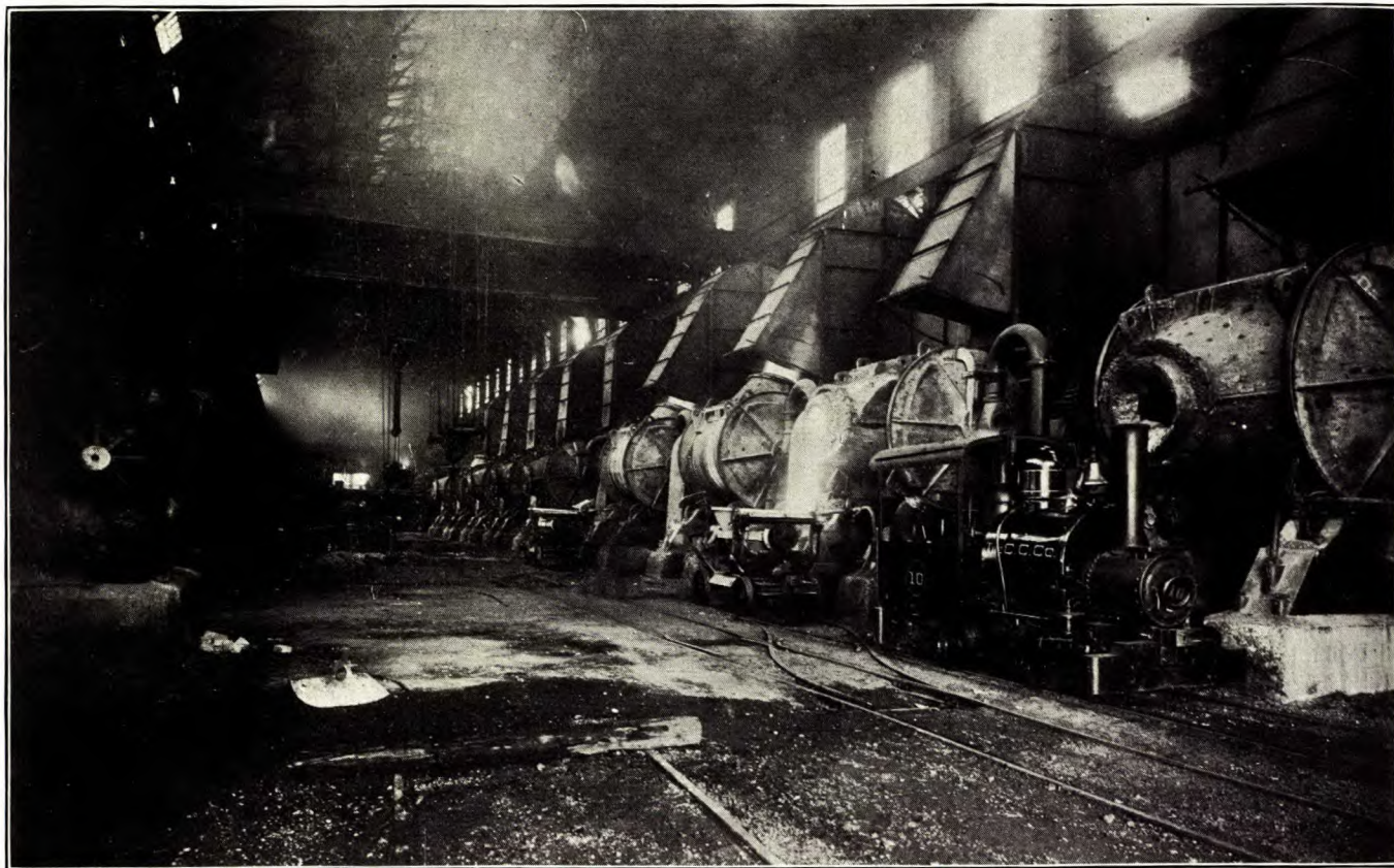
Ancienne installation des convertisseurs acides, Canadian Copper Co., Copper Cliff, Ontario.
