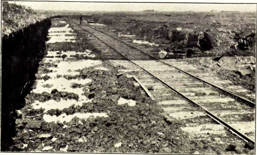
Tranchée d'exploitation à Ökaer, Danemark.
