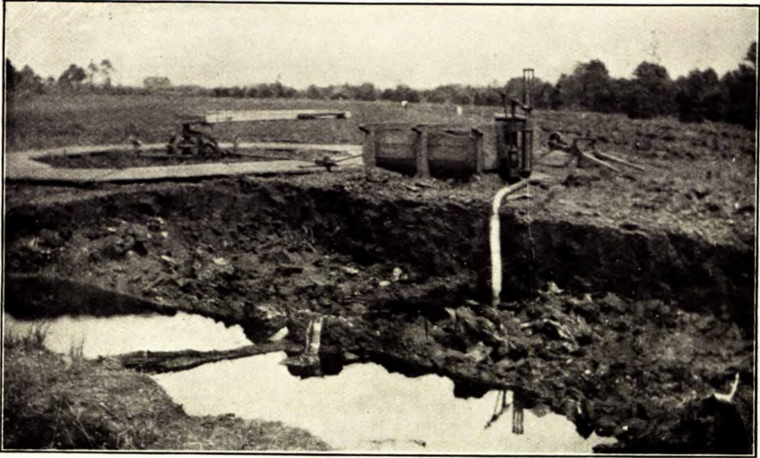
Petite installation à tourbe à Markaryd, Suède.
