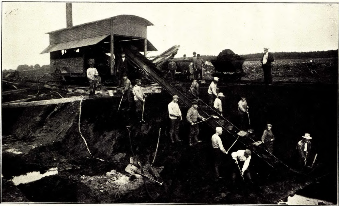
Machine à tourbe Anrep n° I. B. à St. Olof, Suède.
