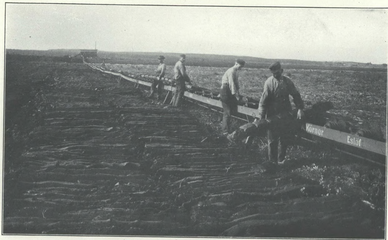
Convoyeur de tourbe à palettes de A. Körner à St. Olof, Suède.
