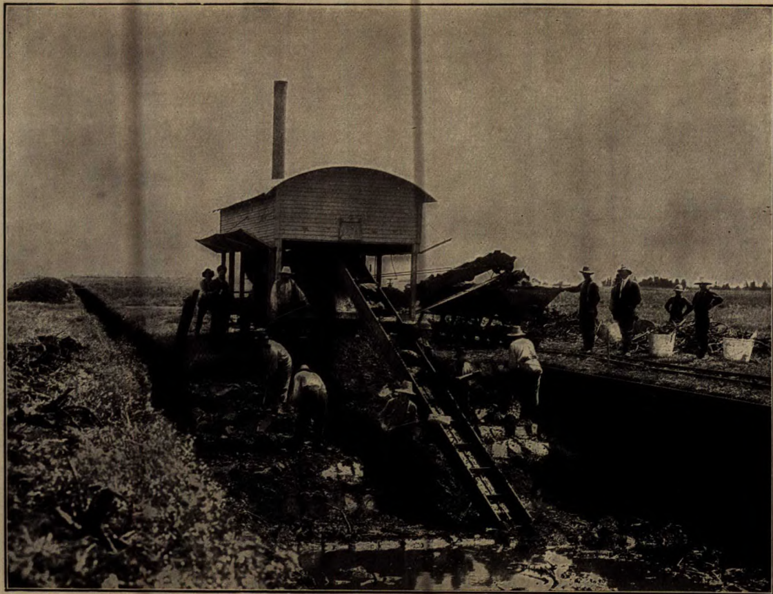
Machine à tourbe Anrep, 30 tonnes ; vue d'ensemble quand elle est en fonctionnement.
