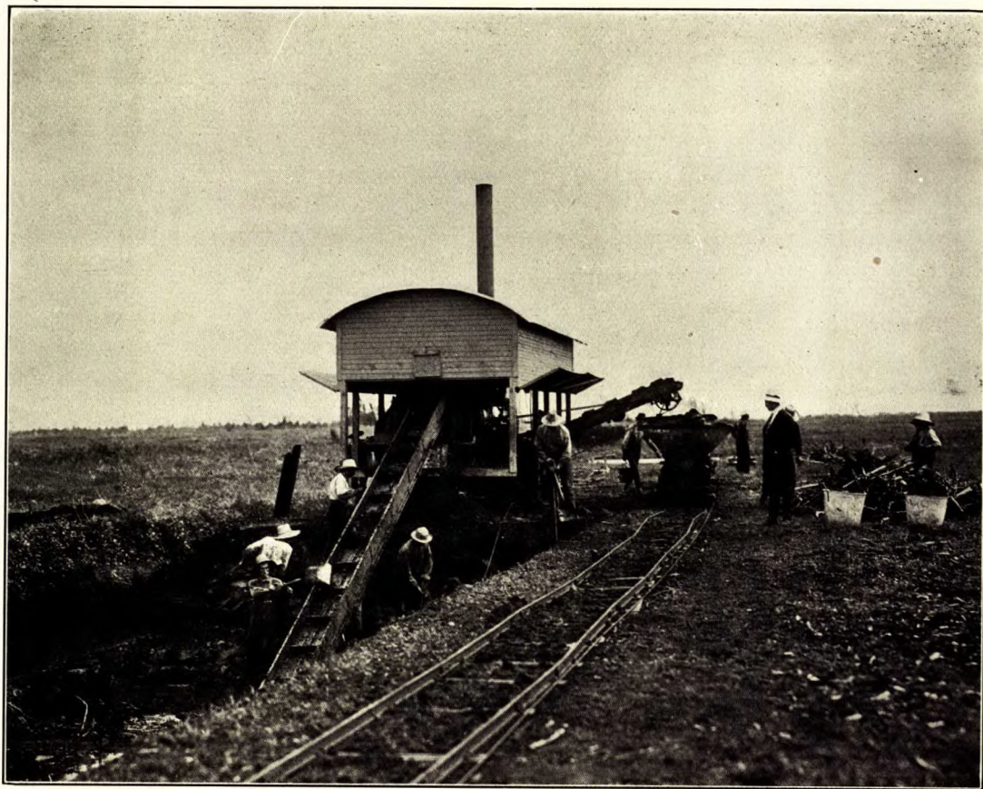
Machine à tourbe Anrep, 30 tonnes ; vue d'une extrémité, laissant voir l'élevateur, les tranchées et la voie ferrée.
