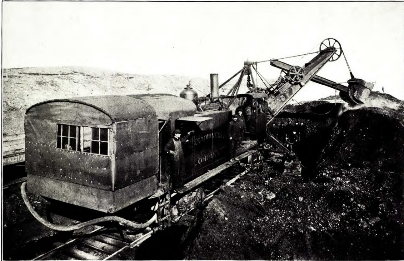
Pelle à vapeur, au chantier de grillage de la Canadian Copper Company, à Copper Cliff.
