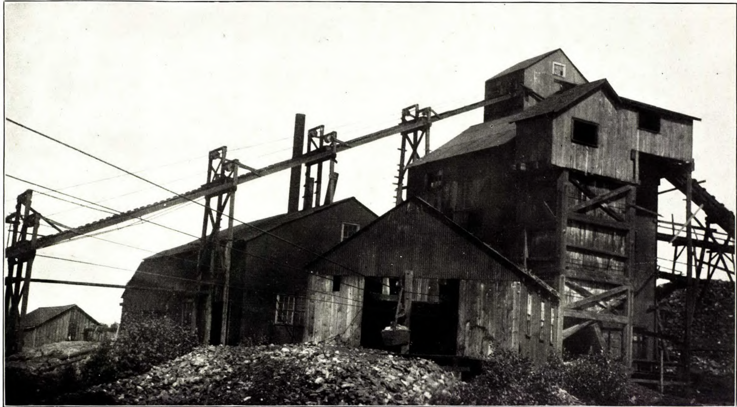
Mine Victoria: hangar à minerai. Benne à minerai sur le câble transporteur.
