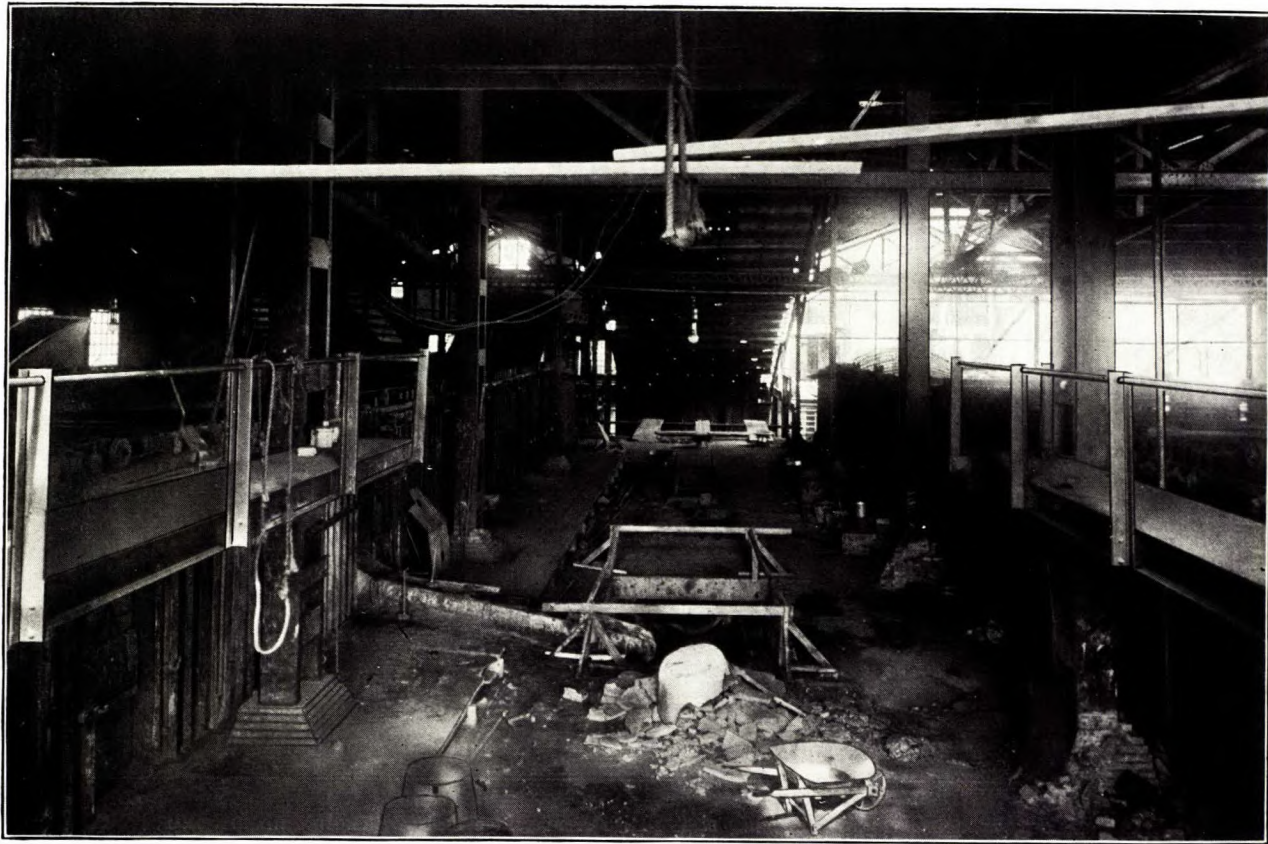
Intérieur du bâtiment du four à réverbère, usines de la Canadian Copper Company, à Copper Cliff.
