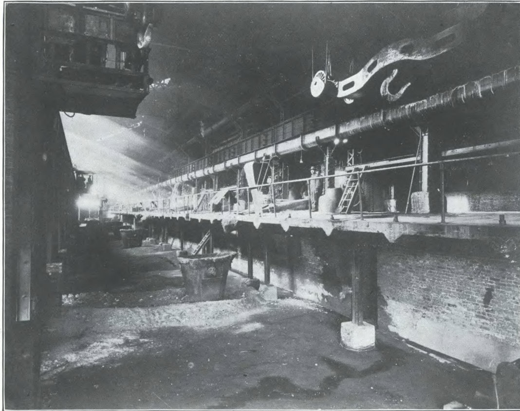
Intérieur de la construction pour le haut fourneau, usines de la Canadian Copper Company, à Copper Cliff.
