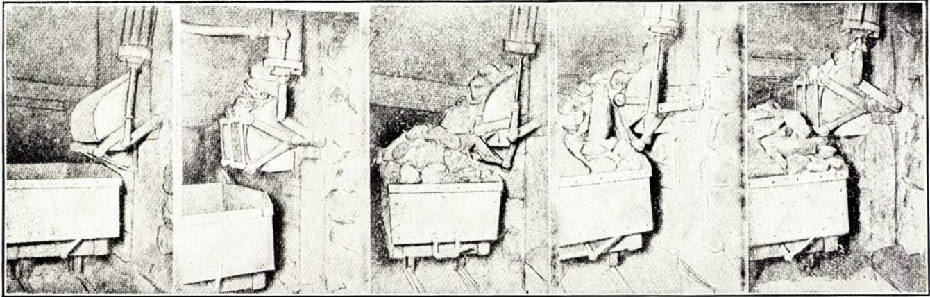
Trappes des couloirs actionnés par l'air comprimé.
