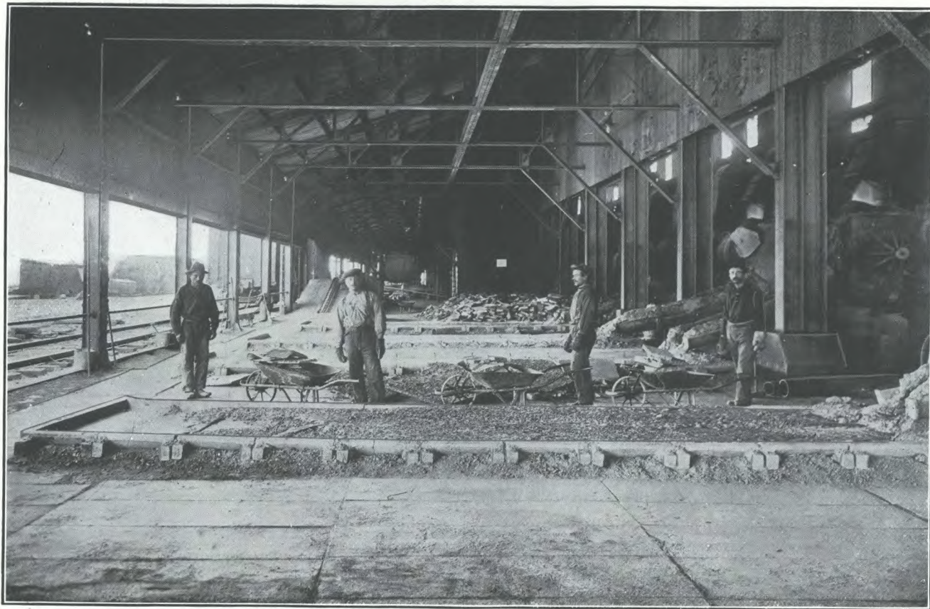
Hangar pour la matte, fonderie de la Canadian Copper Company, à Copper Cliff.
