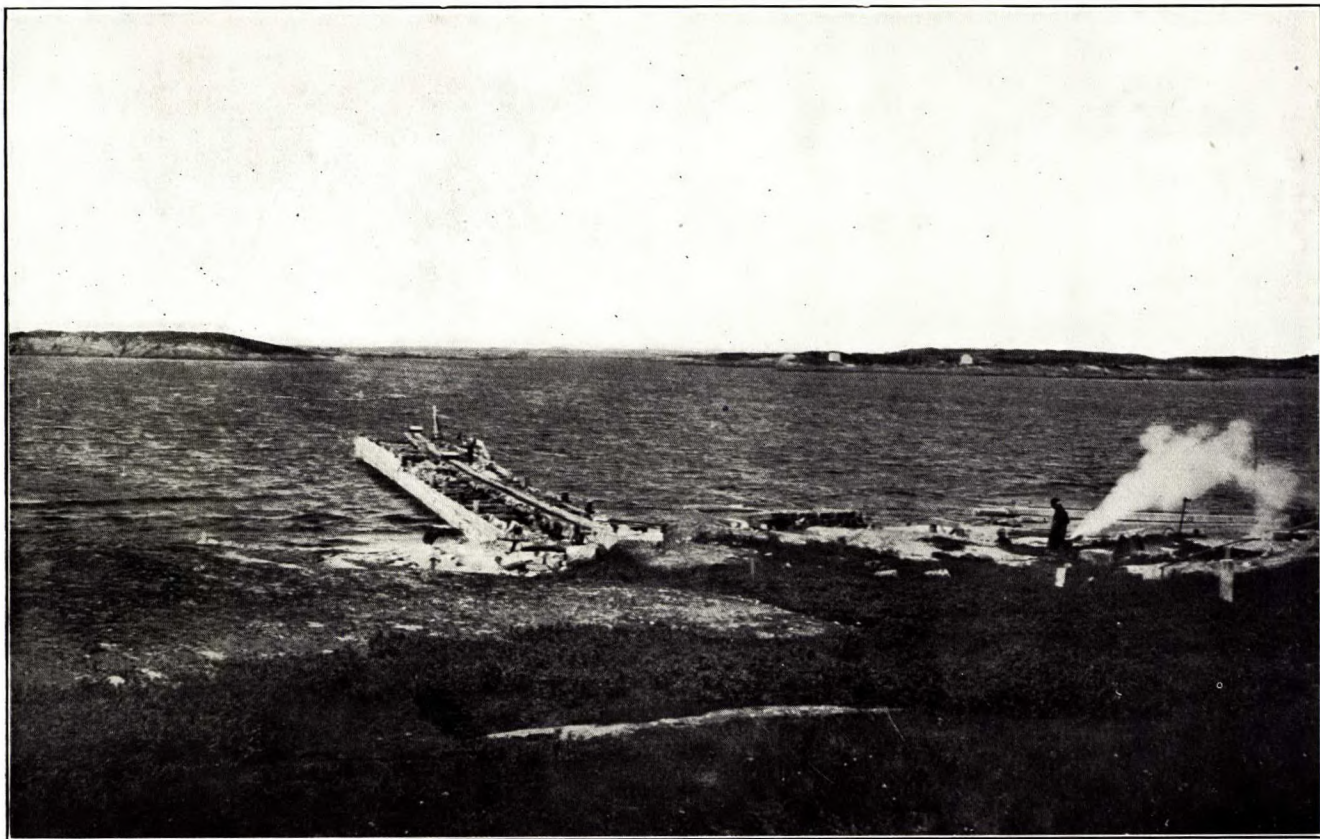
Quai du Gouvernement en voie de construction au Hâvre de Natashkwan.
