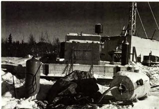
*Essais sur le chantier de chauffe-canalizations ordinaires et de chauffe-canalizations au stade expérimental alimentées au mazout*
