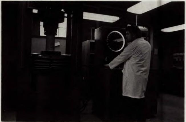
*Ray Chevrier faisant fonctionner une machine utilisée pour les essais de résistance à la compression du béton*
