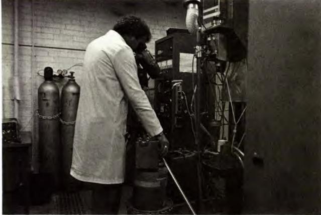
*Four à induction équipé d'un viscosimètre. G. Lemieux, technicien de la céramique mesure l'indice de viscosité des coulées de silice*
