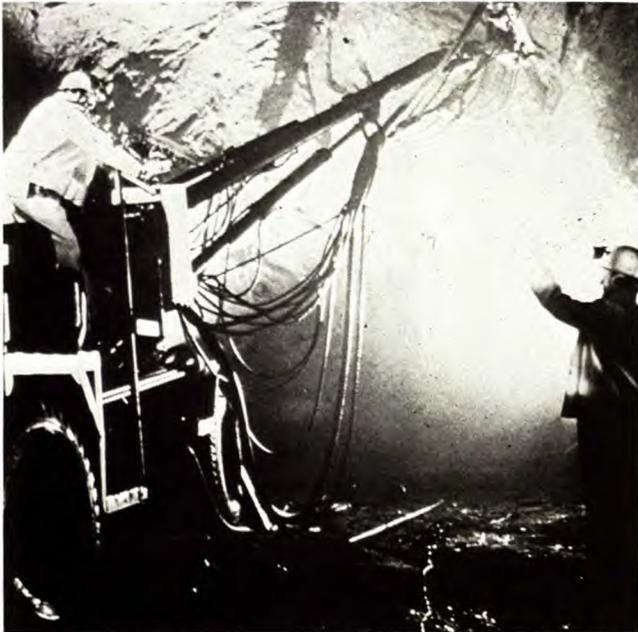
*Forage d'un front de taille-opération minière typique qui peut être la cause de la pollution du milieu souterrain par la poussière, le bruit et les vibrations*
