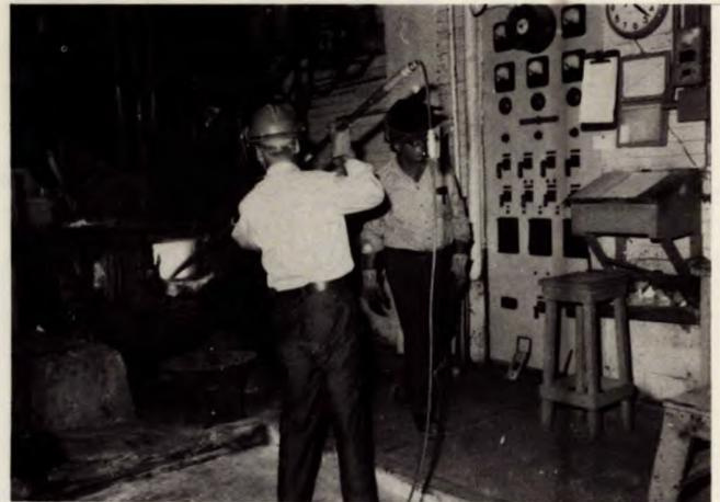
**Figure 11. La température d'un bain d'acier spécial en fusion est mesurée dans un four à arc direct électrique de la fonderie expérimentale.**
