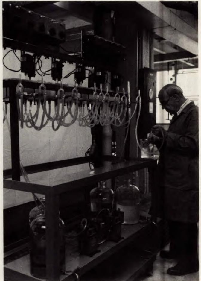
Figure 8. Aux LSM, on poursuit activement les travaux de recherche sur la séparation du zinc, du plomb et du cuivre par un procédé d'extraction au solvant.
