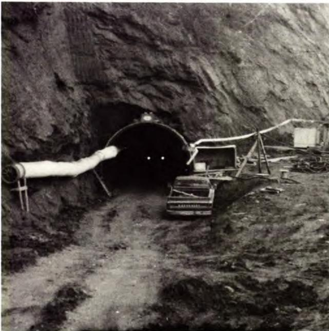
Figure 5. Galerie de dérivation du ruisseau Saline, la première excavation souterraine dans des sables bitumineux.
