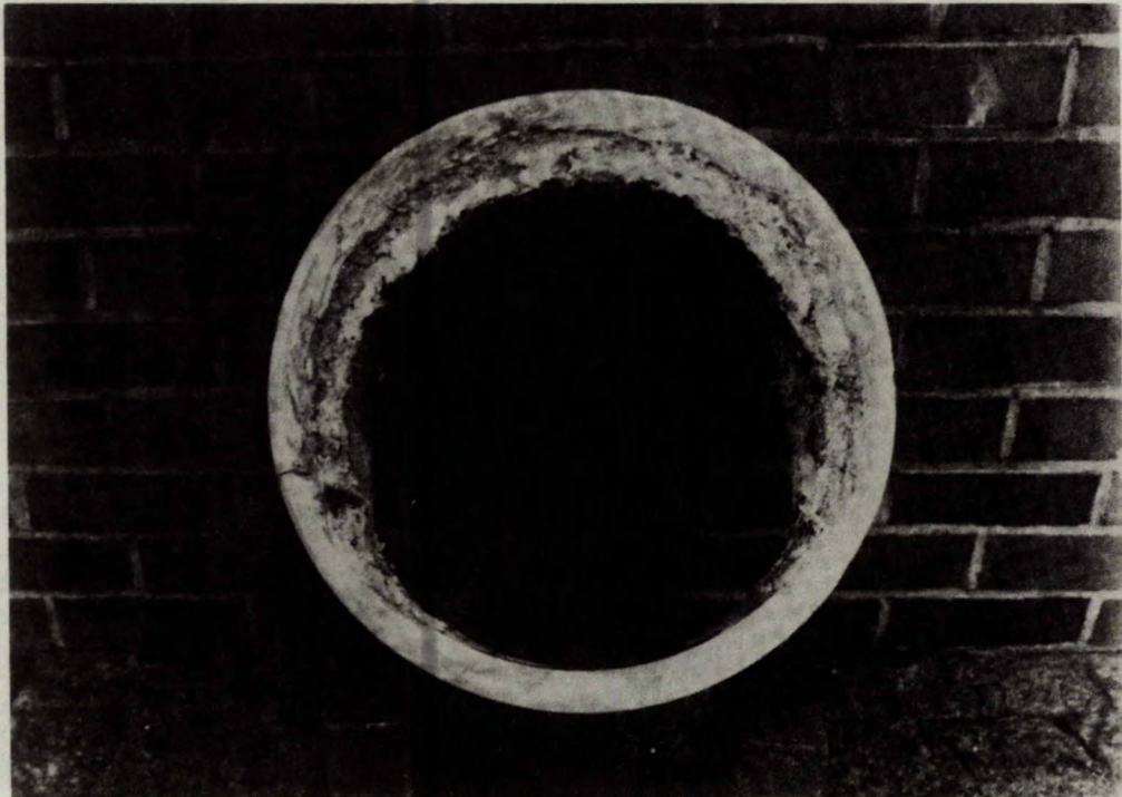
Fig. 2-6 - Formation d'une "niche sociale", à partir de fibres A/C, par les micro-organismes producteurs d'acide sulfurique (44)
