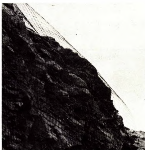
Fig 33 - Une expérience sur le terrain qui utilise des ancrages pour terrains rocheux et un grillage pour étayer mécaniquement une section de paroi.
