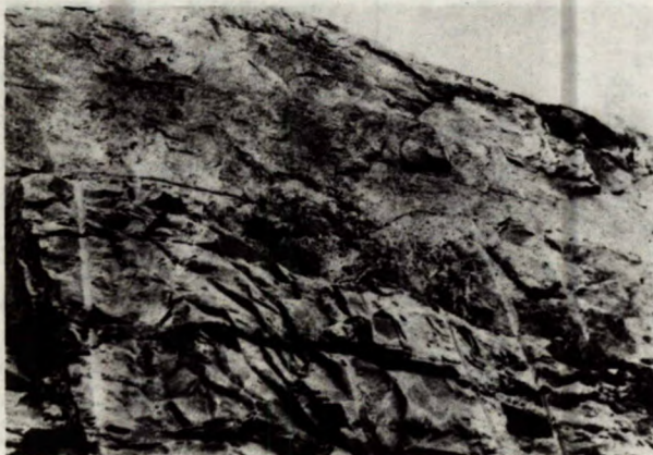
Fig 46 - Surface obtenue par tir à deux temps correspondant à un joint majeur parallèle au front rocheux.
