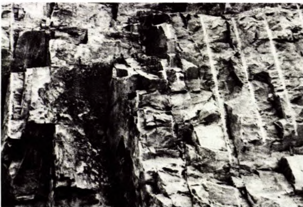
Fig 50 - Diaclases ouvertes à 90^{\circ} par rapport au front.
