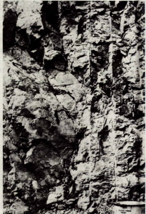
Fig 48 - Rupture par excavation et roche meuble dues à une faille presque parallèle à la ligne de tir à deux temps.
