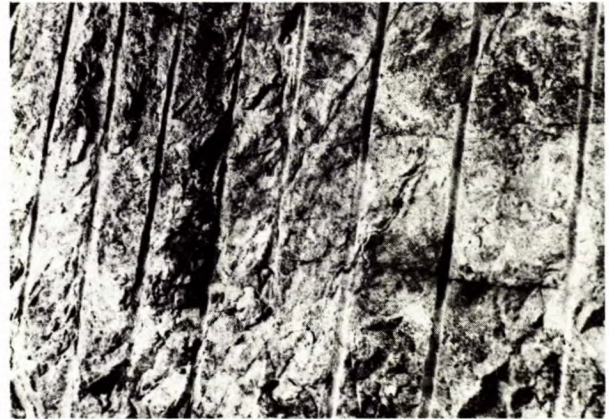
Fig 43 - Surface unie et régulière obtenue par le tir à deux temps dans une roche compétente.
