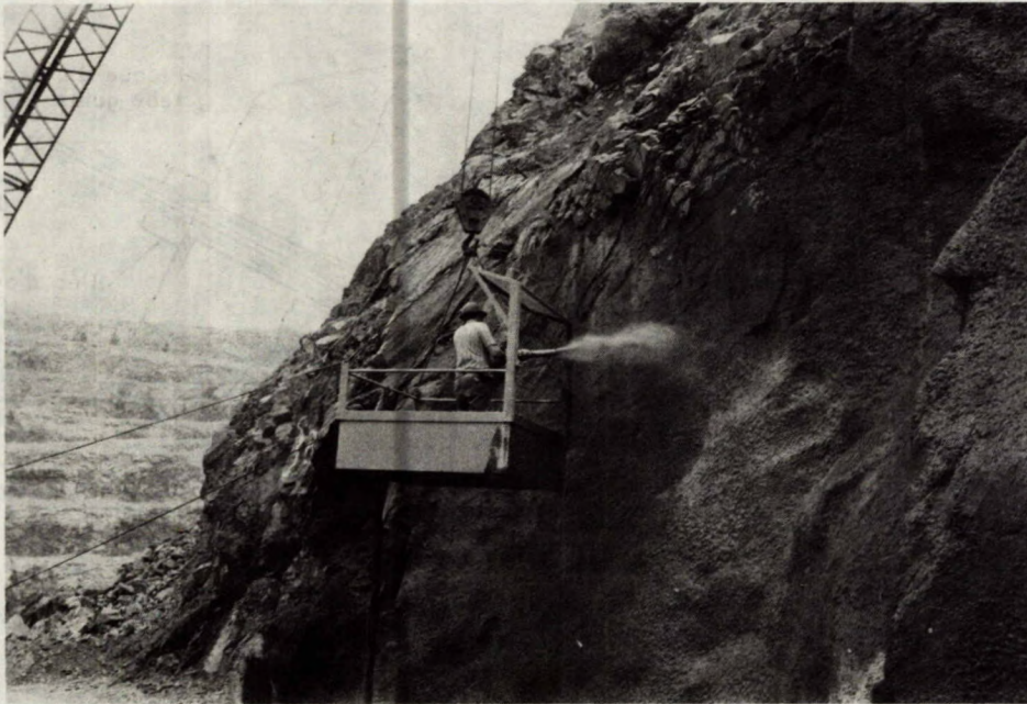
Fig 37 - Soufflage de béton projeté pour stabiliser une paroi de mine.
