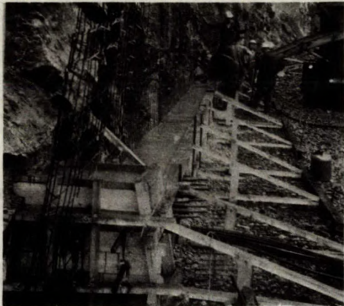
29. Concrete Stringer Poured.
