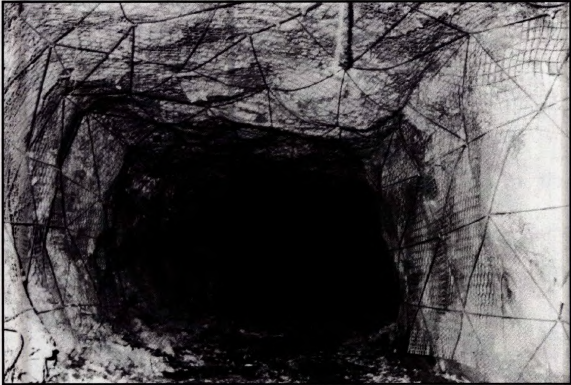
Laçage utilisé dans les zones sujettes aux coups de toit à la mine Strathcona.
