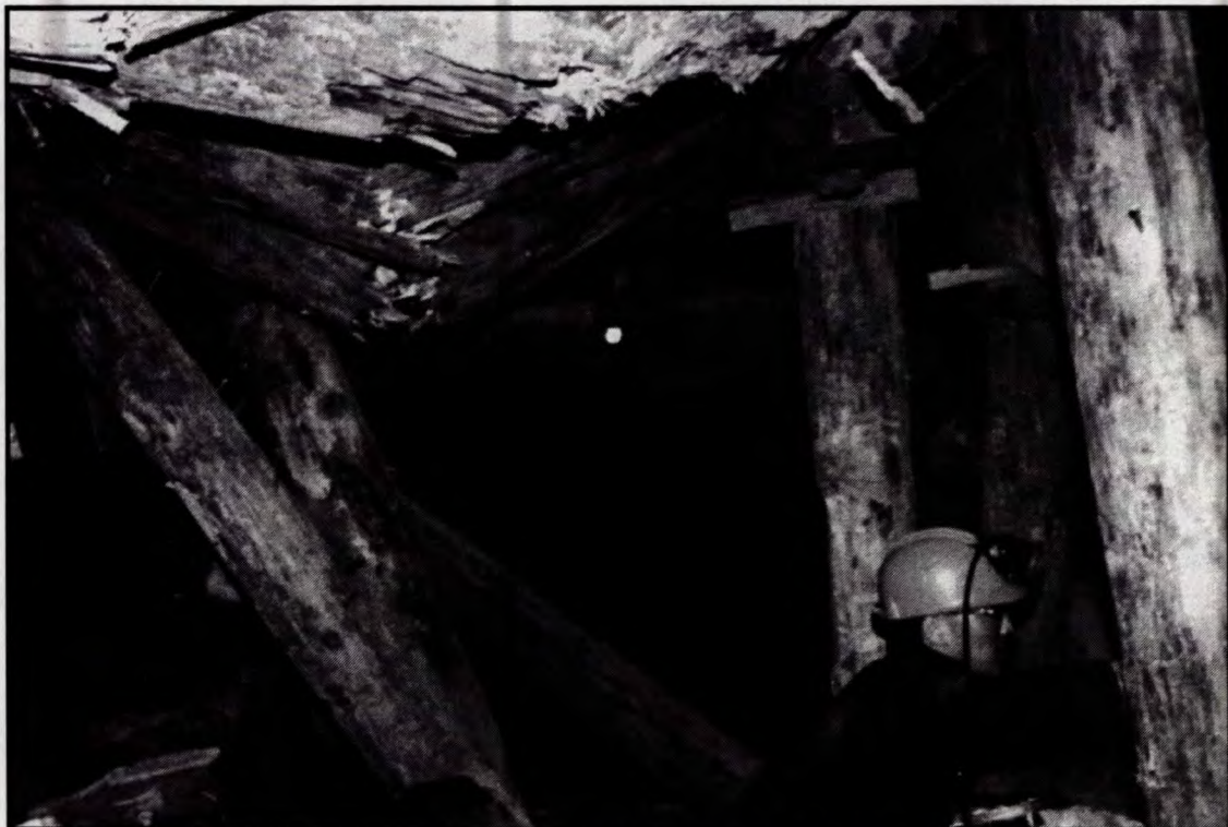
Poteaux et poutres de bois endommagés à la mine Macassa.
