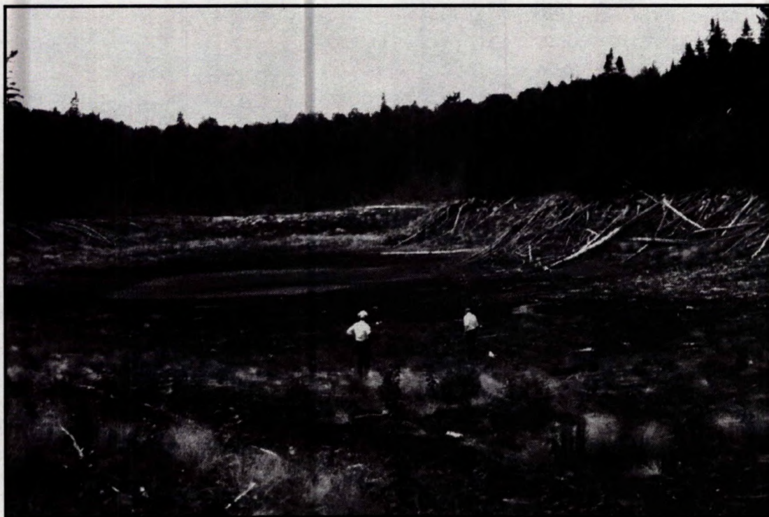
Résultats de la fracturation jusqu'à la surface au-dessus de la zone de coups de toit à la mine Quirke.
