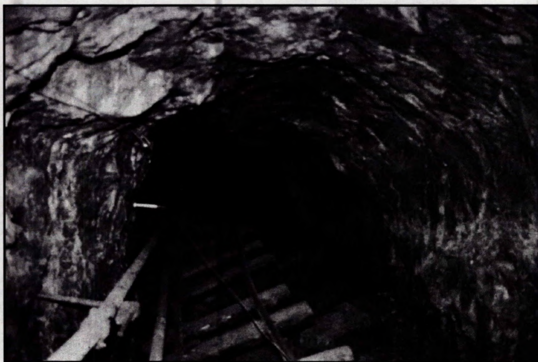
Soulèvement du sol à cause des coups de toit à la mine Campbell.
