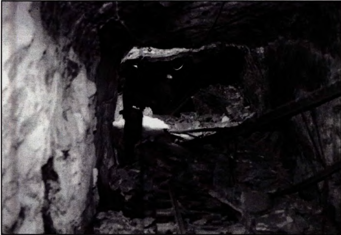
Coup de toit de déformation dans une galerie de la mine Quirke.
