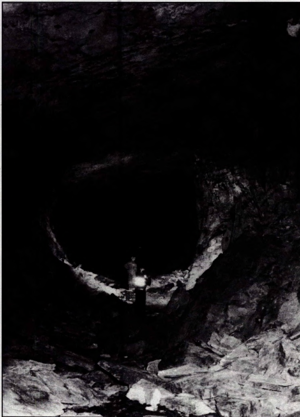
Écroulement de piliers dans une zone de coups de toit à la mine Denison.
