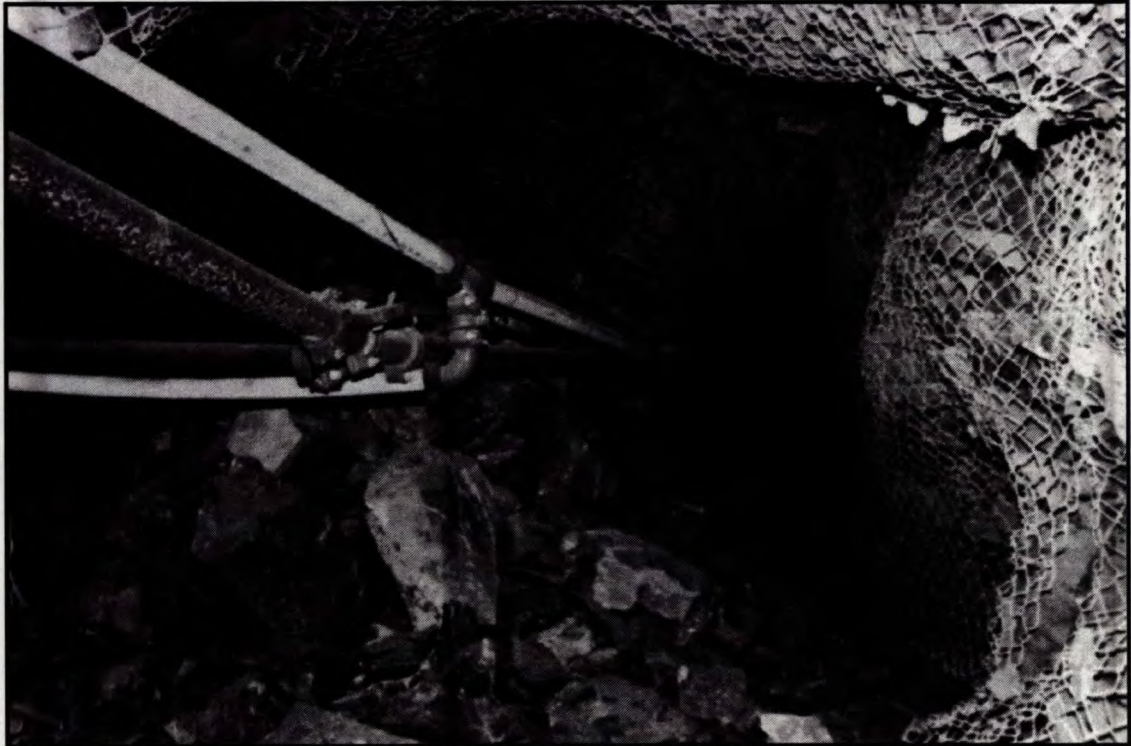
Dégâts dans une galerie de la mine Macassa environ un an après une opération de relâchement des contraintes du pilier adjacent.
