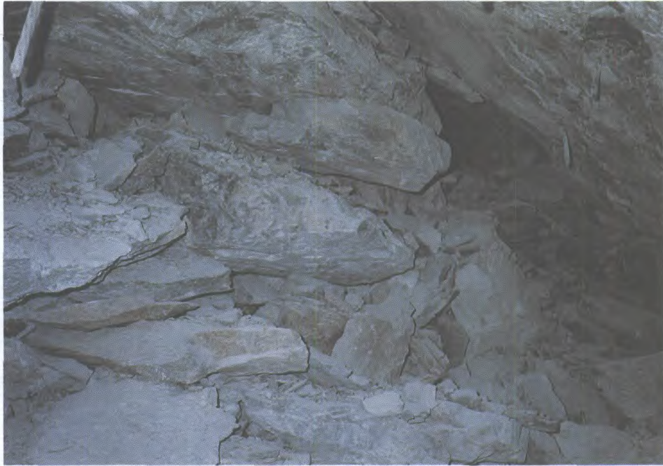
Plus de 800 tonnes de roche ont été déplacées par suite de deux petits coups de toit (2,0 Mn) dans une galerie de halage isolée dans la mine Strathcona
