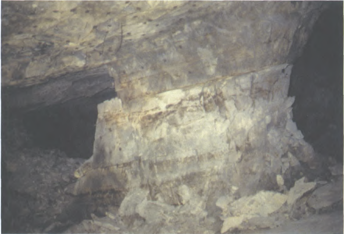
Pilier de panneau dans la mine Denison. Le toit semble s'être déplacé en amont-pendage par rapport au mur.
