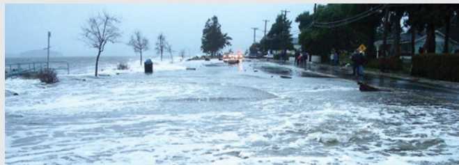
FIGURE 23 : Marée de tempête sur l'autoroute Sunshine Coast (route 101) à la baie Davis, le 6 février 2006 (photo gracieuseté de B. Oakford).
